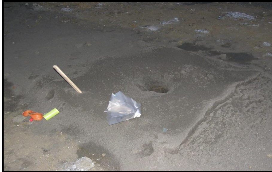
Figura 15. Cono de perforación mal formado. (Fuente: Simón, 2013).
