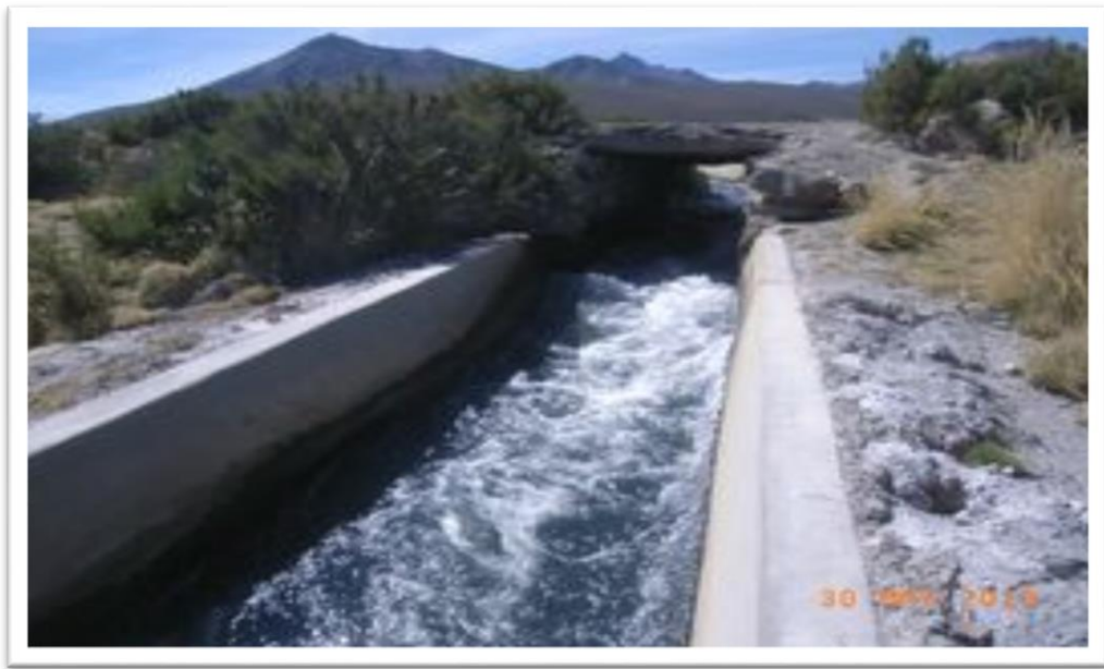
Figura 25: Fuente de agua en km 22+000
