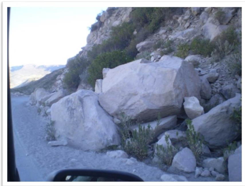
Figura 13: Caída de bloques y bloques obstruyendo el ancho de calzada
