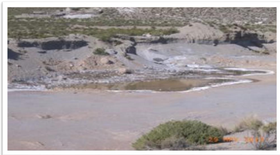
Figura 30: Depósito de Km. 14+000 - lado derecho de trocha de carretera de Candarave - Binacional
