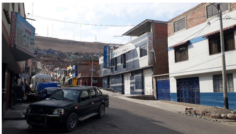
Presencia de Viviendas con evacuación de agua pluvial
