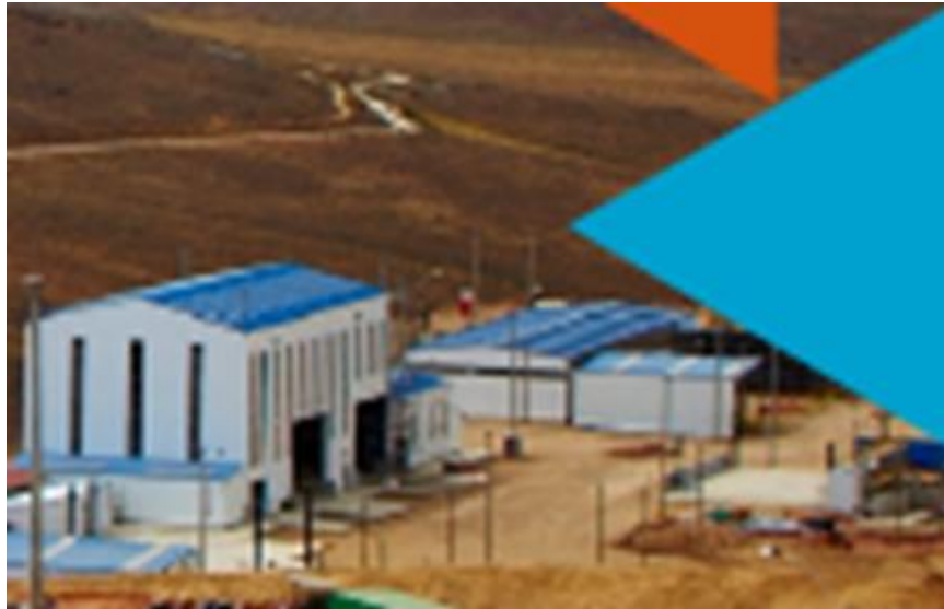
Figura 2. Taller de mantenimiento truck shop Fuente: Compañía minera Minsur Pucamarca, 2015.
