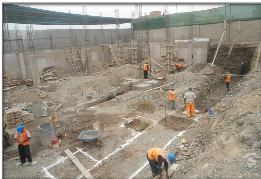
Foto 6: Avances de obra en Sótano del hotel 3 estrellas
