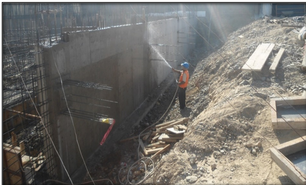
Foto 5: Empalmes de vigas en sótano del proyecto: "Hotel 3 estrellas"
