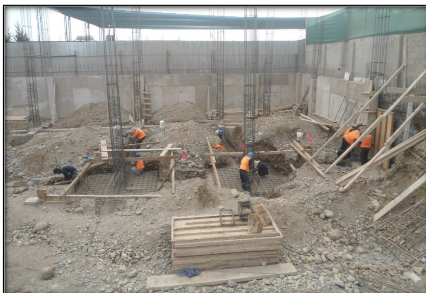
Foto 8: Zapatas, columnas y vigas de cimentación en sótano del hotel 3 estrellas
