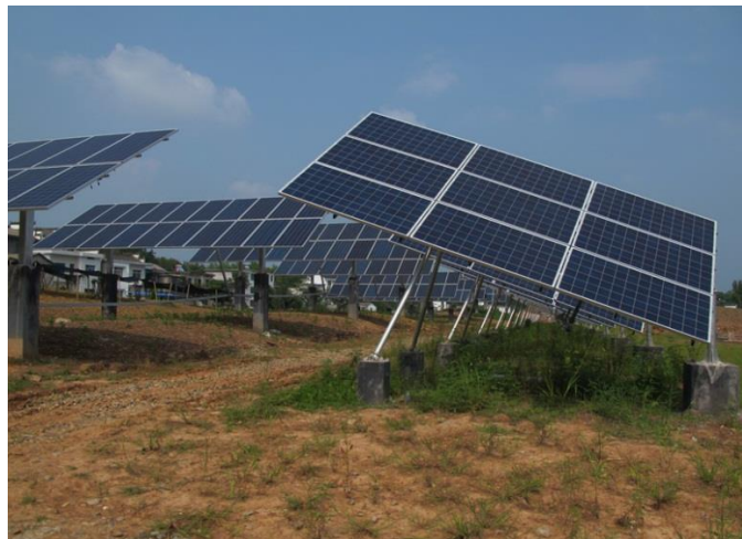
Figura 26. Campo Solar de seguidores con paneles fotovoltaicos de un solo eje en Huangshan – Anhui. (Recuperado de: http://www.chrunsol.com/project_show.aspx?id=13 , 2016)
