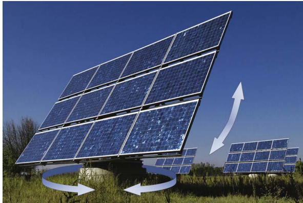
Figura 27. Campo Solar de seguidores con paneles fotovoltaicos de a dos ejes y montura altazimutal (Recuperado de: https://www.linkedin.com/pulse/solar-tracker , 2016)
