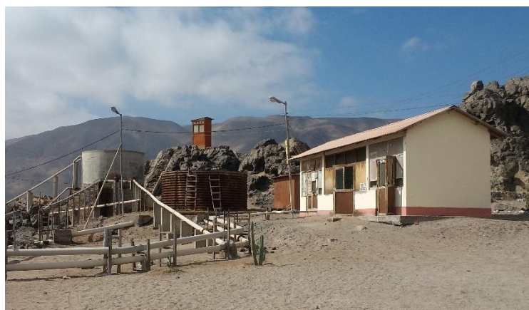
IMAGEN N°23 - MÓDULOS DE LA ZONA DE SERVICIO
