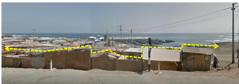
IMAGEN N°31 – VIVIENDAS PUERTO GRAU
