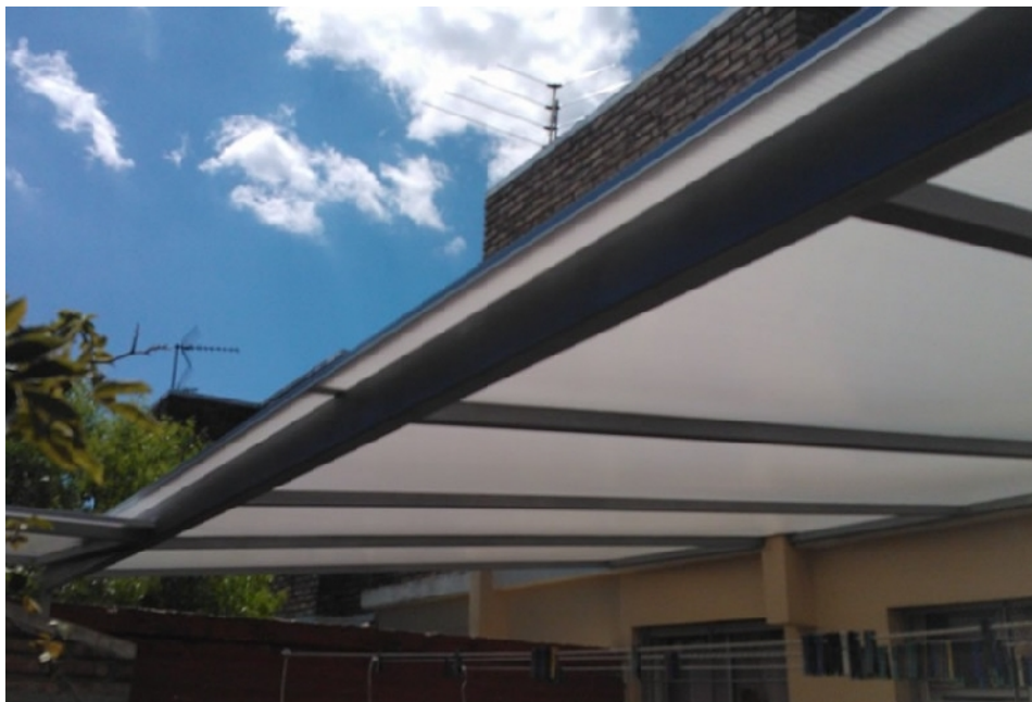
Figura 12. Aplicación de Policarbonato alveolar en techo de vivienda
