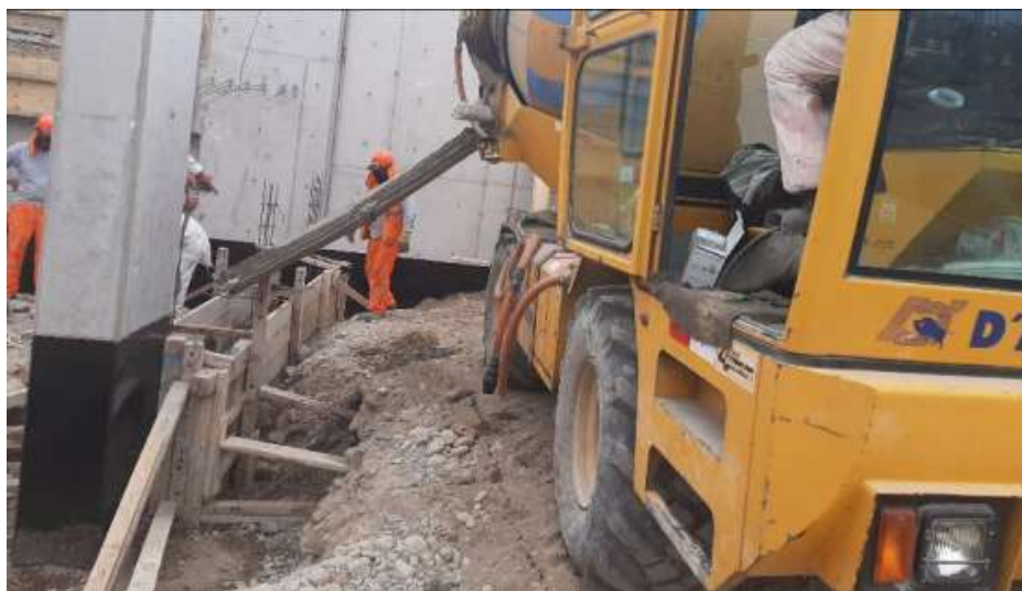
Fotografía 18. Encofrado y concreto ciclópeo en cimientos corridos Fuente: Elaboración propia
