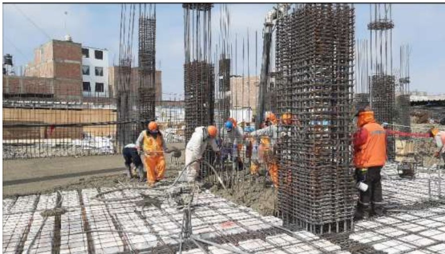
Fotografía 10. Concreto premezclado en losa aligerada Fuente: Elaboración propia
