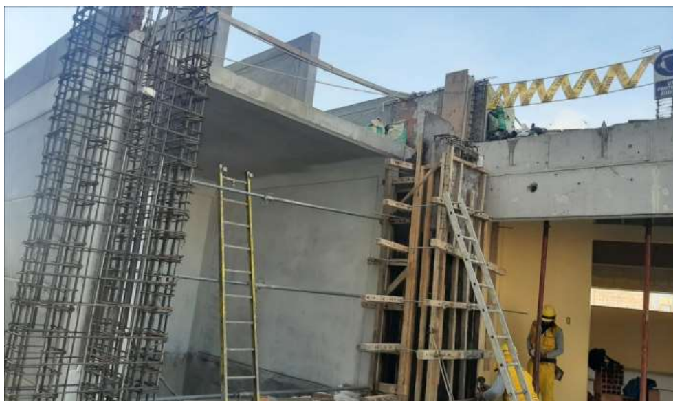
Fotografía 29. Encofrado y concreto en columnas -Puente. Fuente: Elaboración propia
