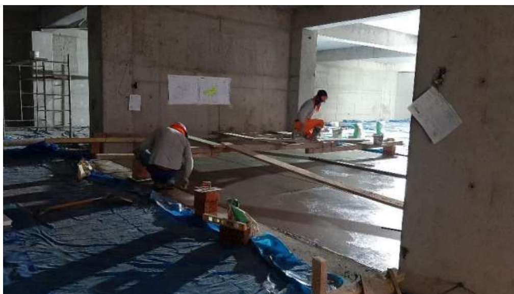
Fotografía 12. Piso de cemento pulido en sótano -Sede central Fuente: Elaboración propia
