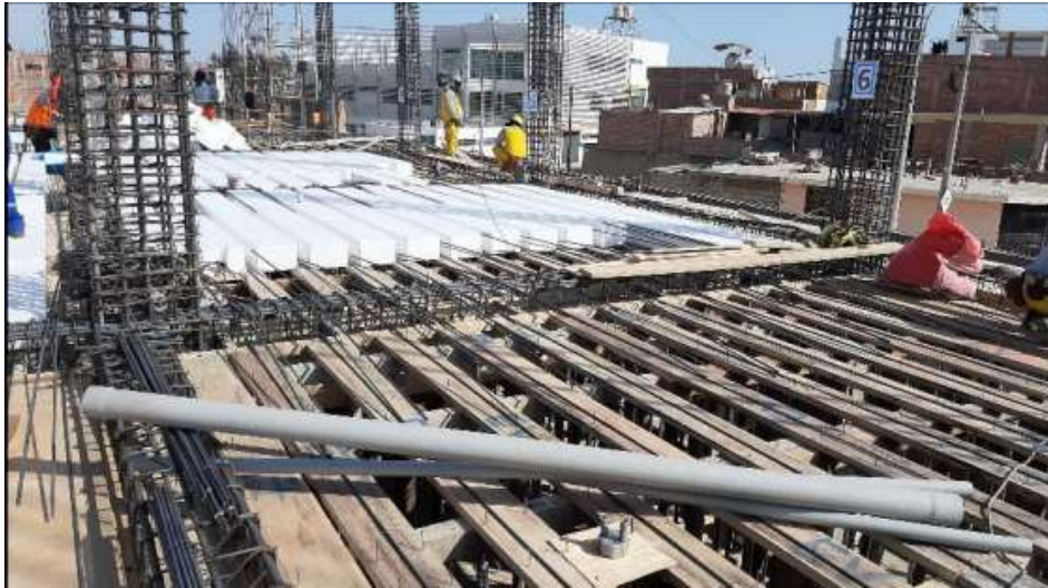
Fotografía 21. Encofrado de losa aligerada en edificio PET Fuente: Elaboración propia
