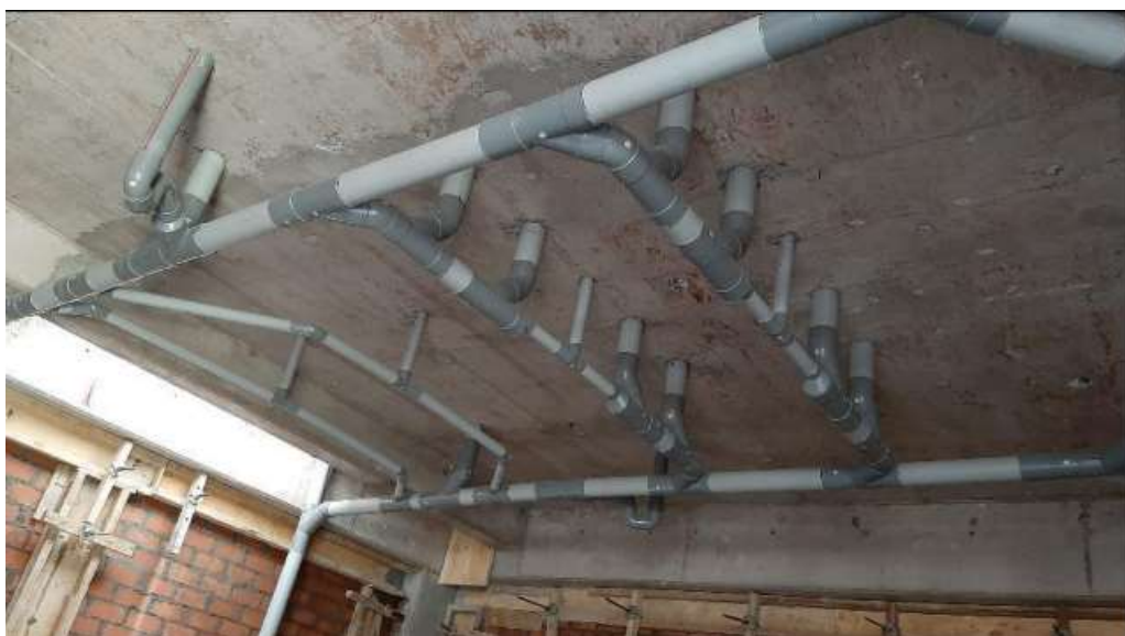
Fotografía 16. Instalaciones de tubería para desagüe Fuente: Elaboración propia
