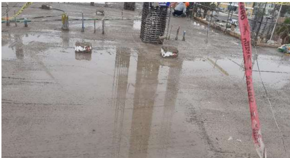
Fotografía 36. Curado de concreto en losa aligerada Fuente: Elaboración propia
