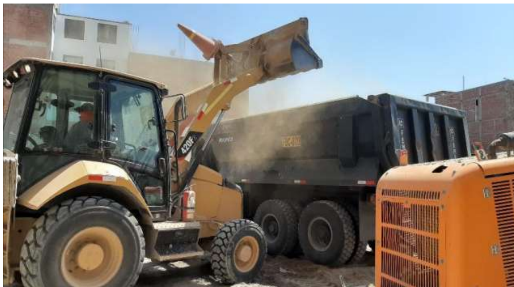
Fotografía 37. Eliminación de material excedente Fuente: Elaboración propia
