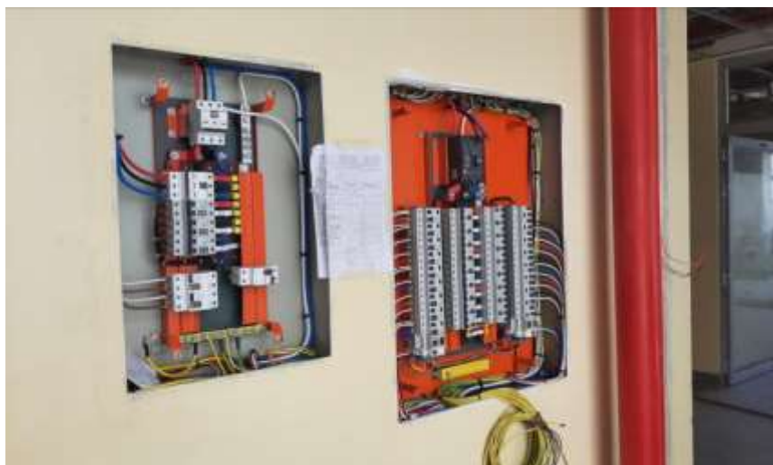
Fotografía 26. Instalación de tableros eléctricos Fuente: Elaboración propia
