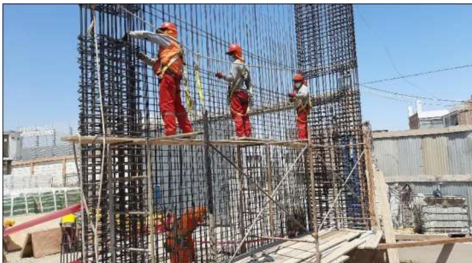
Fotografía 19. Acero en placas y columnas Fuente: Elaboración propia
