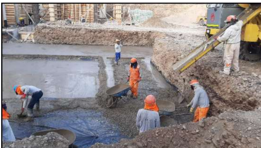
Fotografía 5. Solado en zapatas de edificio central Fuente: Elaboración propia
