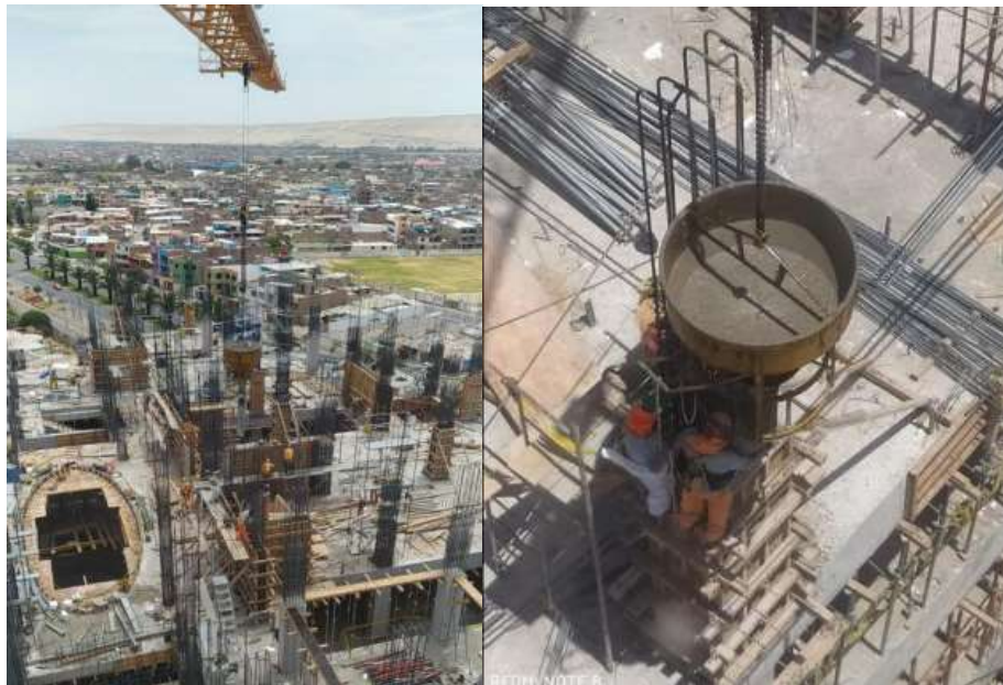
Fotografía 9. Encofrado y concreto en columnas Fuente: Elaboración propia
