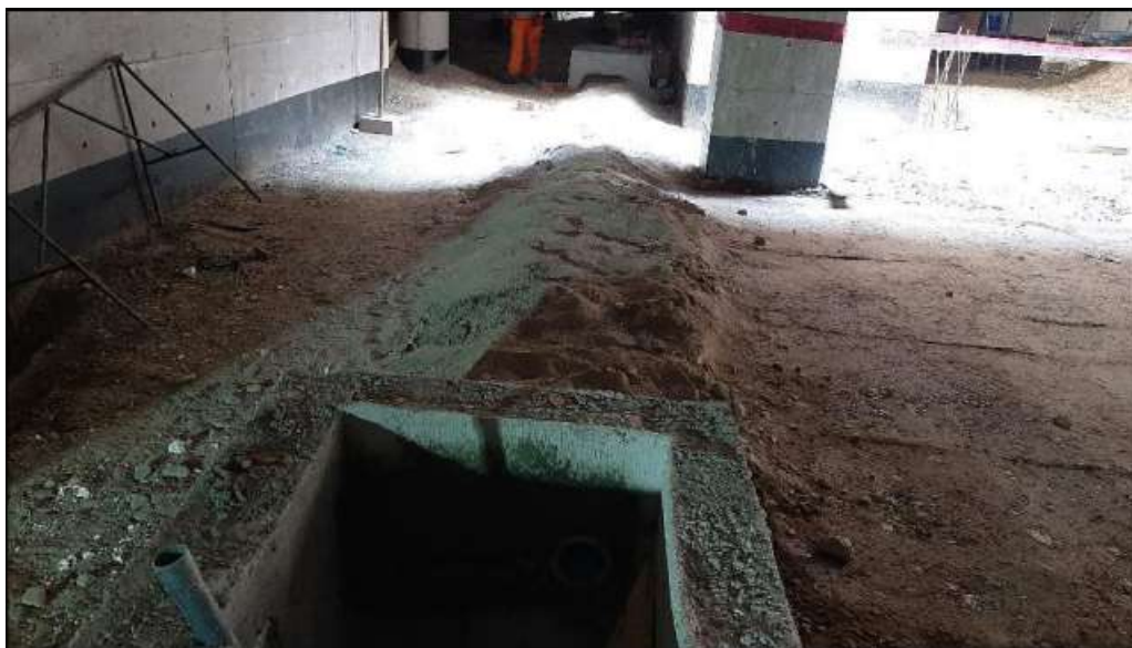
Fotografía 15. Instalación eléctrica en buzón de concreto Fuente: Elaboración propia
