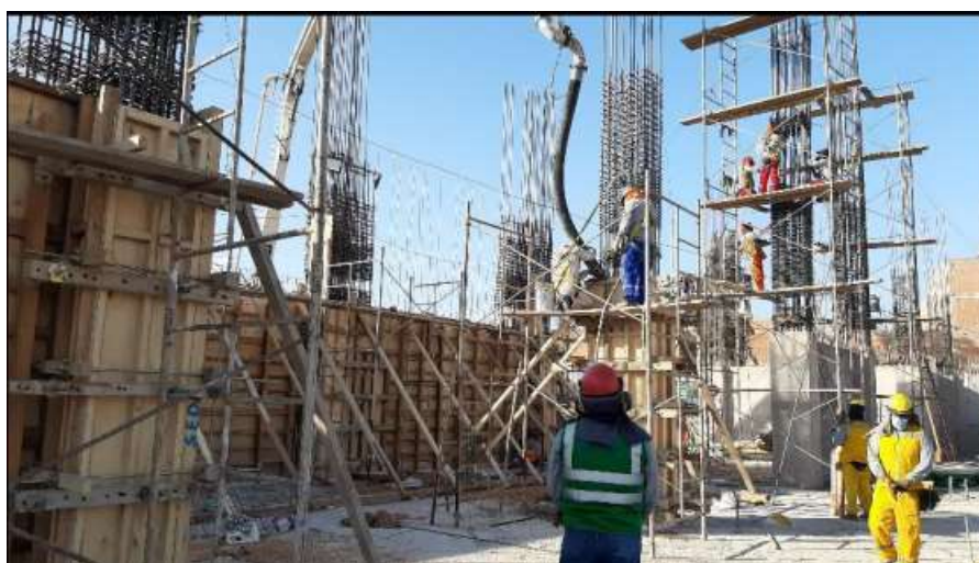
Fotografía 6. Acero, encofrado y concreto en placas y columnas Fuente: Elaboración propia
