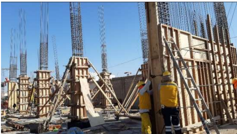
Fotografía 20. Encofrado en placas y columnas Fuente: Elaboración propia
