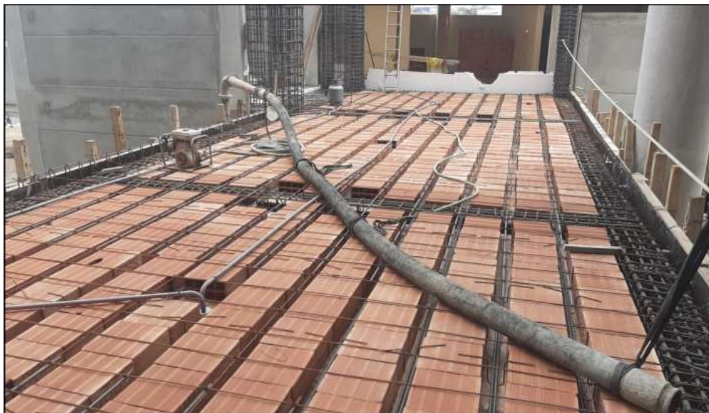
Fotografía 31. Encofrado y concreto en losa aligerada -Puente. Fuente: Elaboración propia
