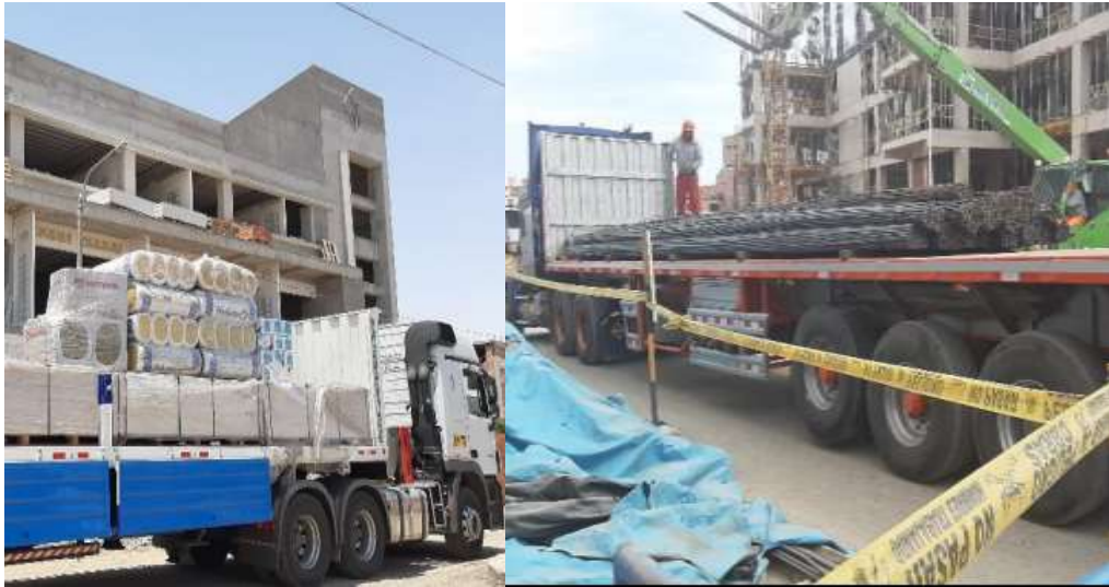
Fotografía 4. Transporte de materiales Fuente: Elaboración propia
