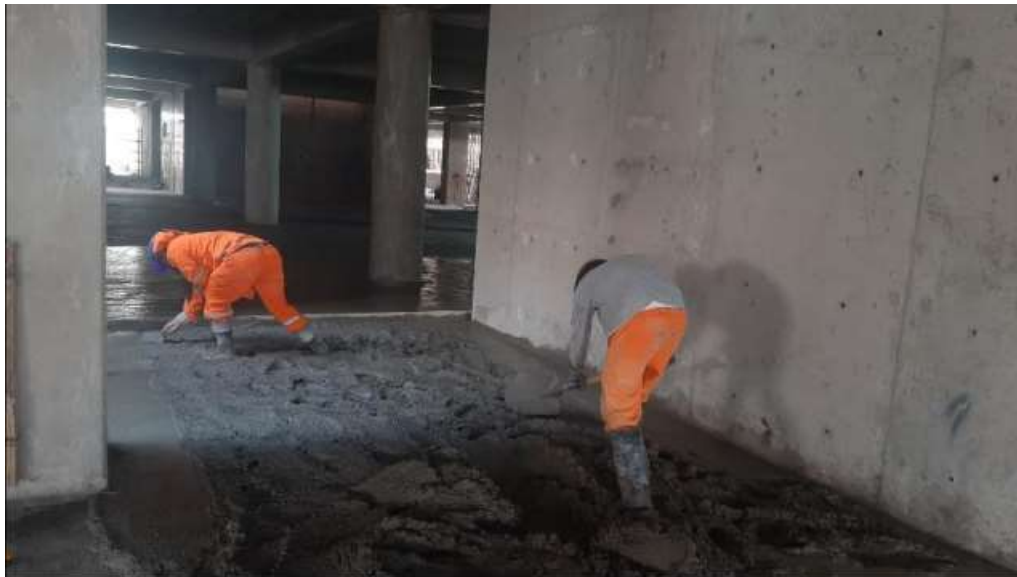
Fotografía 13. Contrapiso en semisótano Fuente: Elaboración propia
