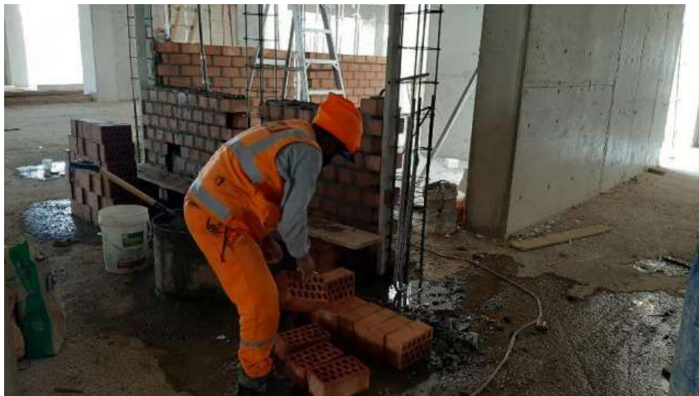
Fotografía 11. Muro de ladrillo KK tipo cabeza -Sede central Fuente: Elaboración propia
