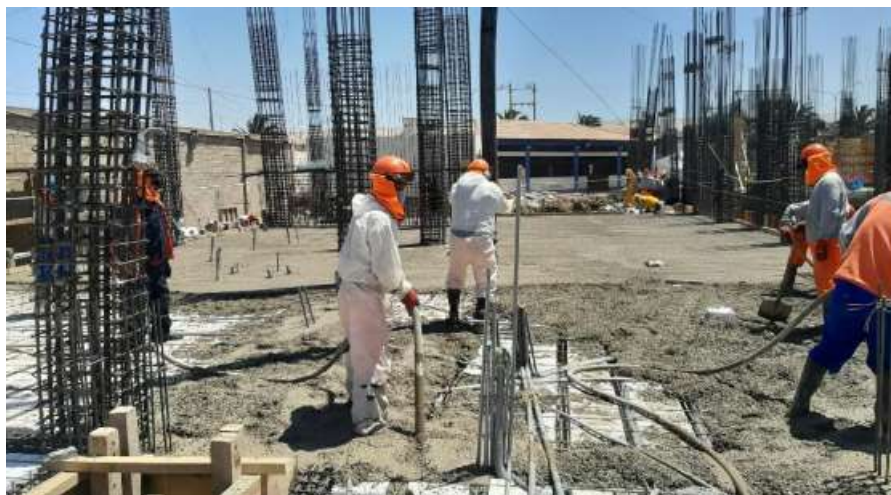
Fotografía 23. Concreto premezclado en losa aligerada Fuente: Elaboración propia
