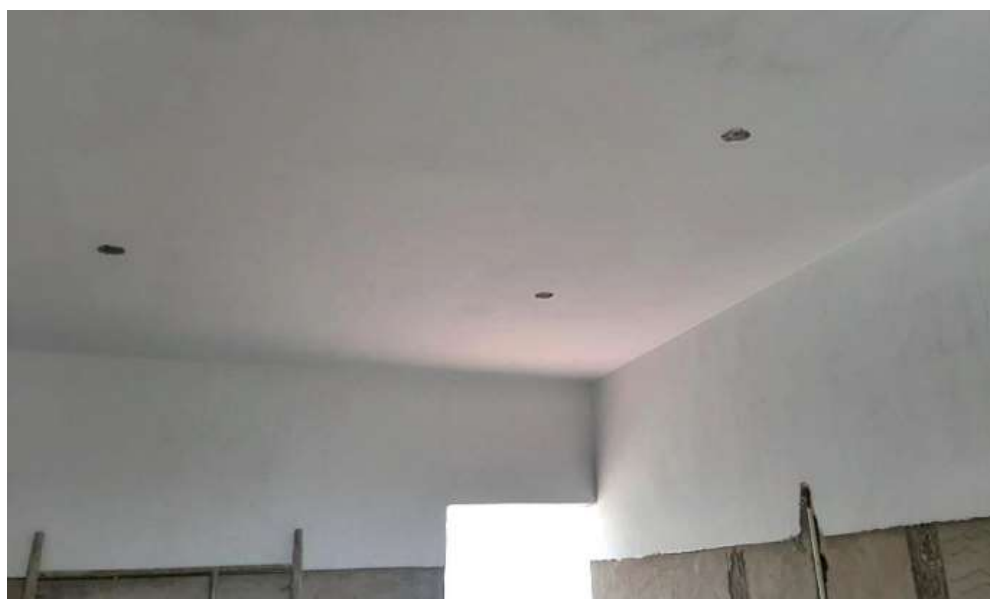
Fotografía 34. Pintura Látex en cielo raso Fuente: Elaboración propia
