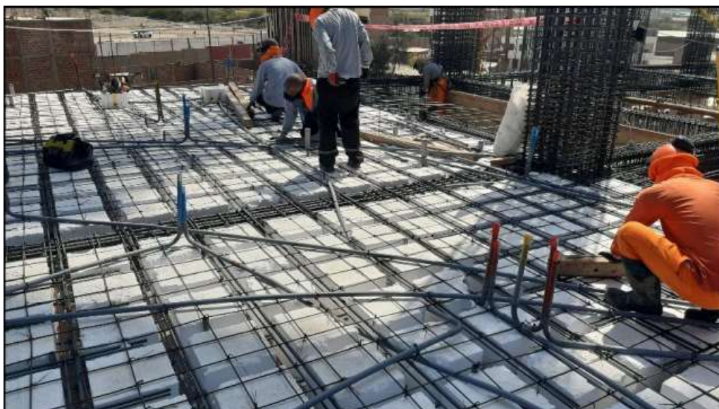
Fotografía 14. Instalación de tuberías PVC SAP Fuente: Elaboración propia
