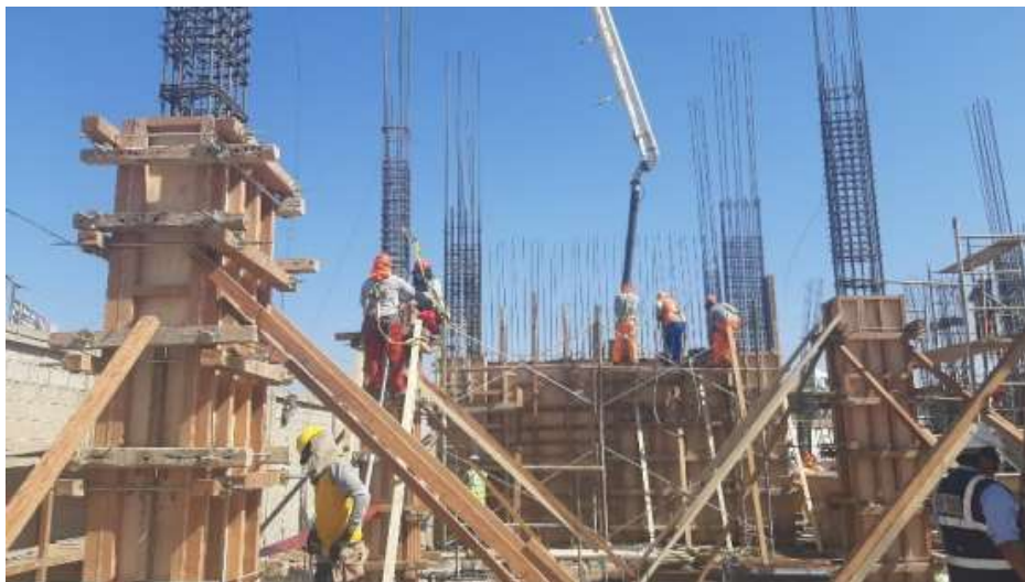
Fotografía 22. Concreto premezclado en columnas y placas Fuente: Elaboración propia
