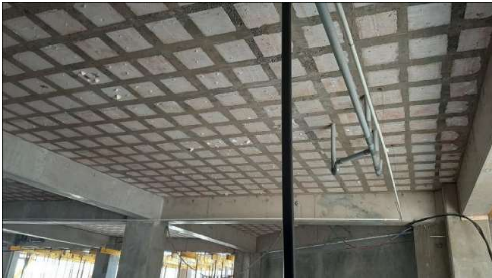
Fotografía 17. Instalación de tuberías de red de agua y accesorios Fuente: Elaboración propia
