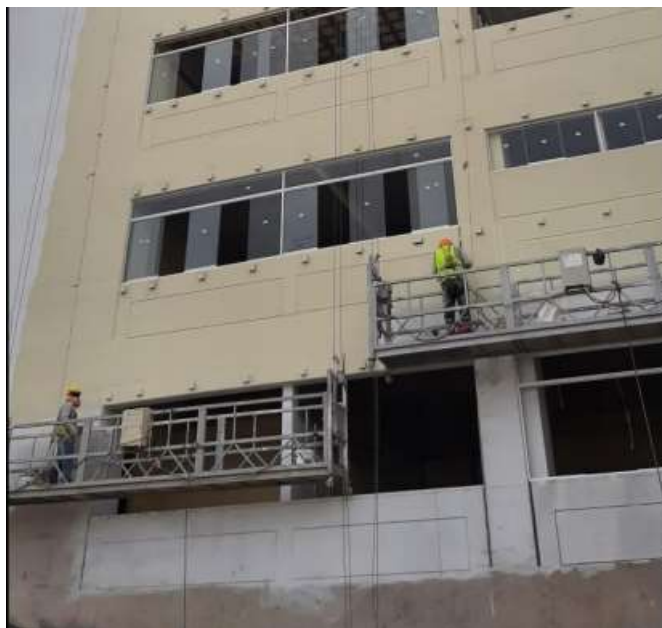
Fotografía 35. Pintura en muros exteriores Fuente: Elaboración propia
