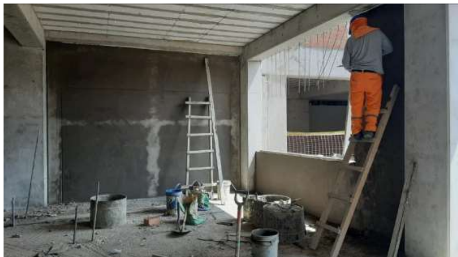
Fotografía 24. Tarrajeo de muros interiores. Bloque B. Fuente: Elaboración propia
