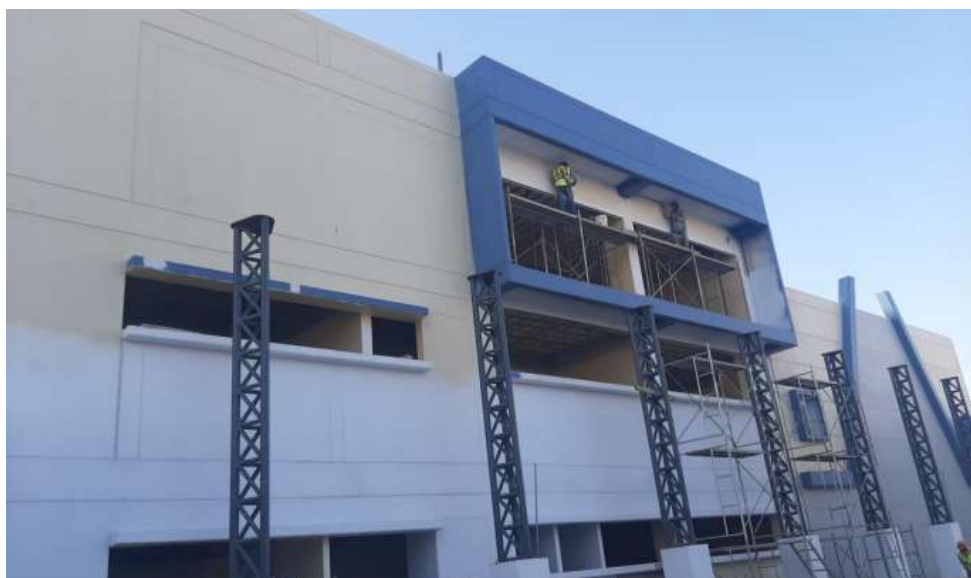
Fotografía 33. Pintura Látex en muros exteriores Fuente: Elaboración propia
