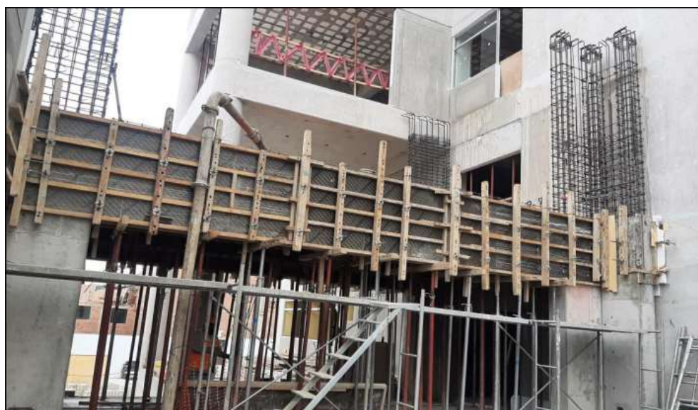
Fotografía 30. Encofrado y concreto en vigas -Puente. Fuente: Elaboración propia
