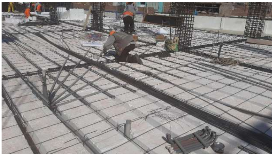
Fotografía 27. Instalación de tuberías eléctricas Pabellón B. Fuente: Elaboración propia
