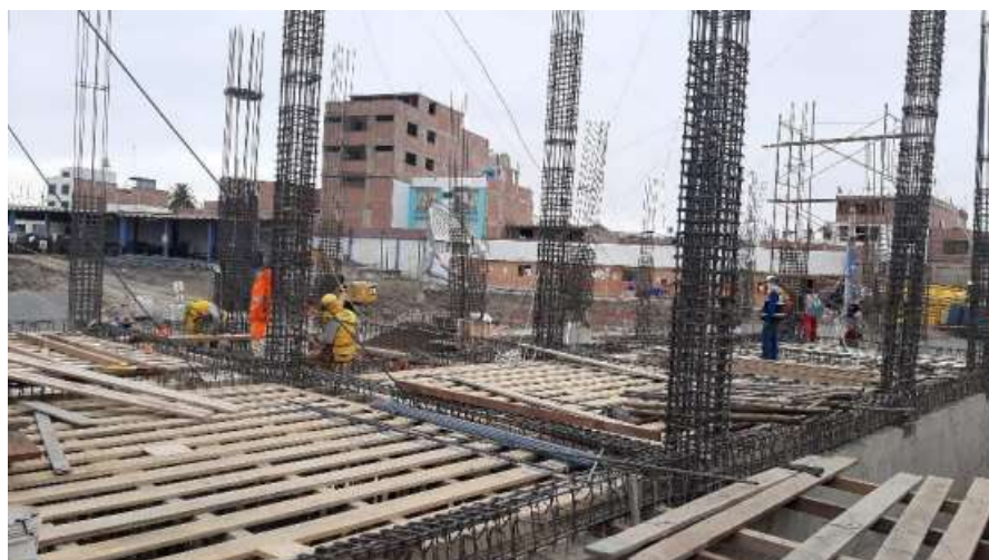
Fotografía 8. Encofrado y concreto de losa aligerada Fuente: Elaboración propia
