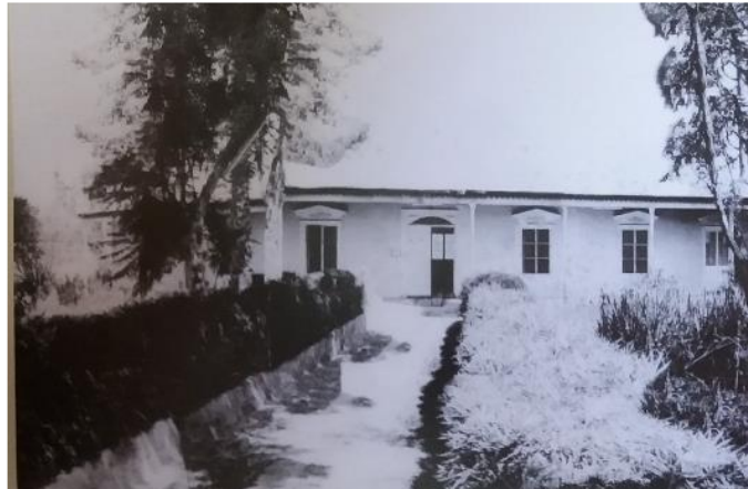
Figura 16. El espacio urbano y el encuentro con la ciudad construida
