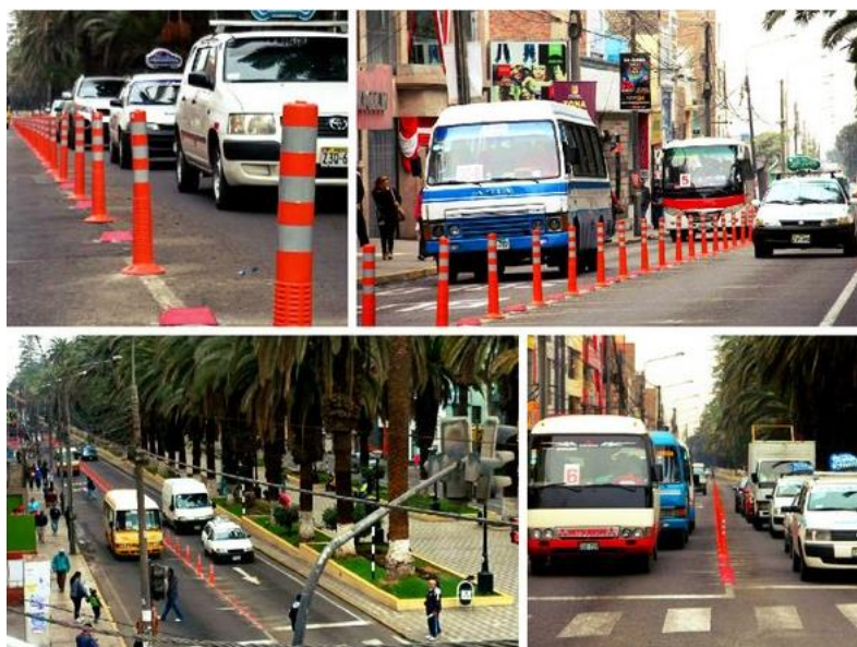
FIGURA N°3: Separadores instalados en av. Bolognesi
