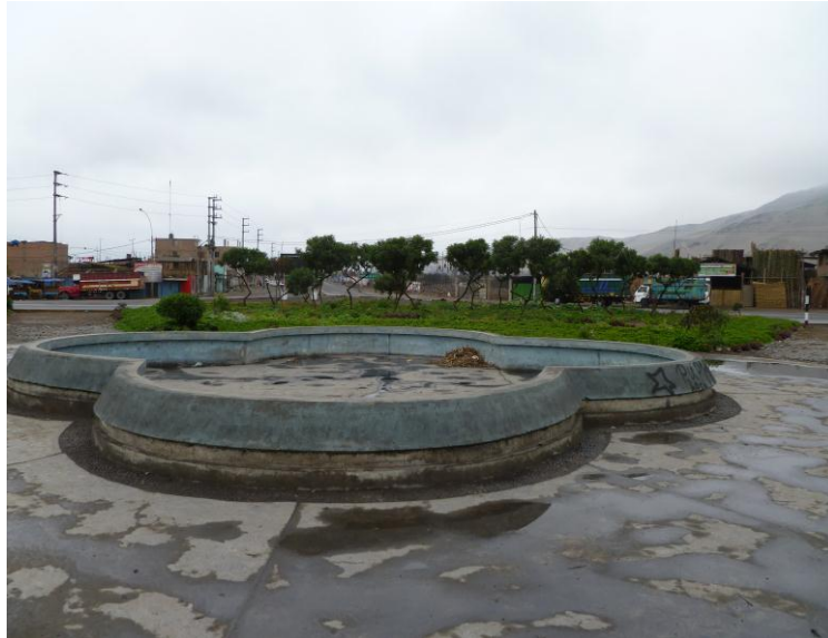
Figura 56. Vista panorámica del óvalo Chancay.
