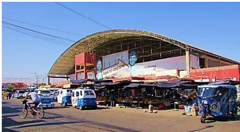
Figura 64: Exteriores del Mercado Santa Rosa. Fuente: Elaboración propia, muestra de campo.
