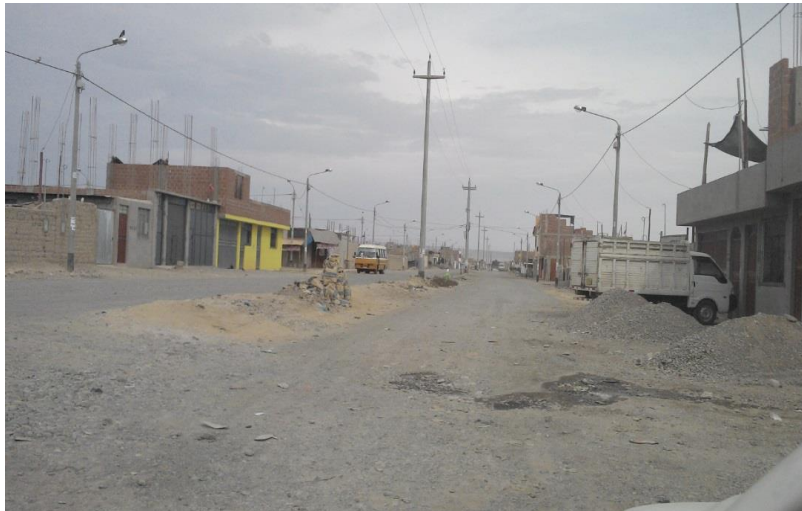
Figura 94: Construcciones de sistema provisional. Fuente: Elaboración propia.
