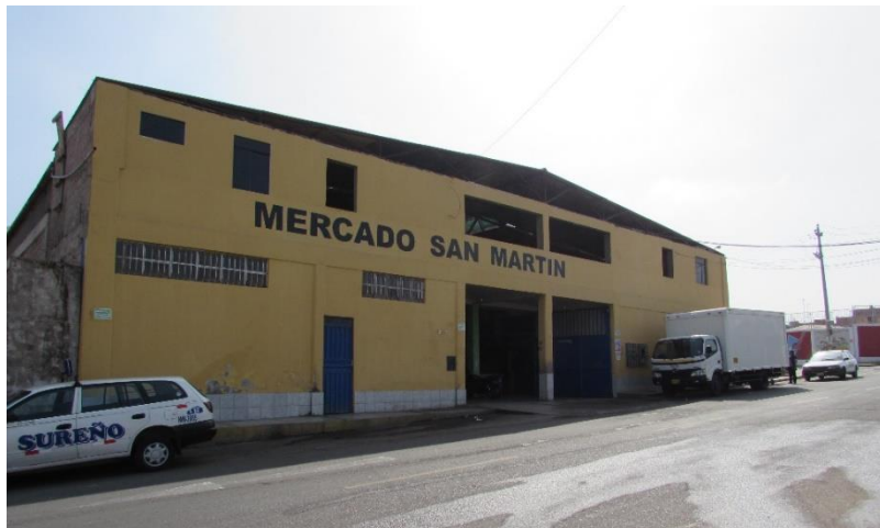
Figura 65: Exteriores del Mercado San Martín. Fuente: Elaboración propia, muestra de campo.
