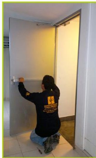
Puerta y marco cortafuego de una hoja certificada RF 3 Horas con barra antipánico tipo push
