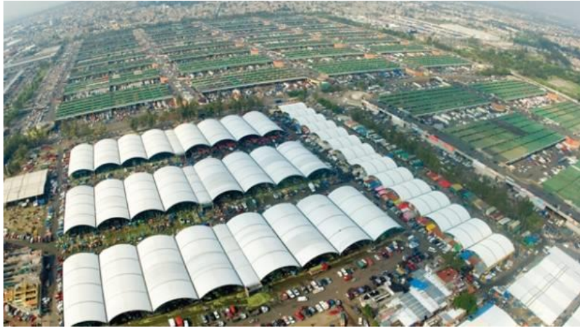
Figura 50: Central de Abasto de México
