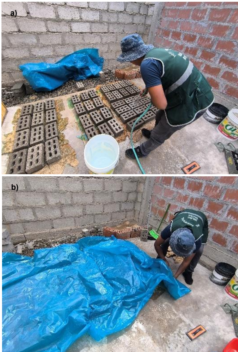
Fotografía 4. Curado del ladrillo ecológico durante 8 y 28 días
