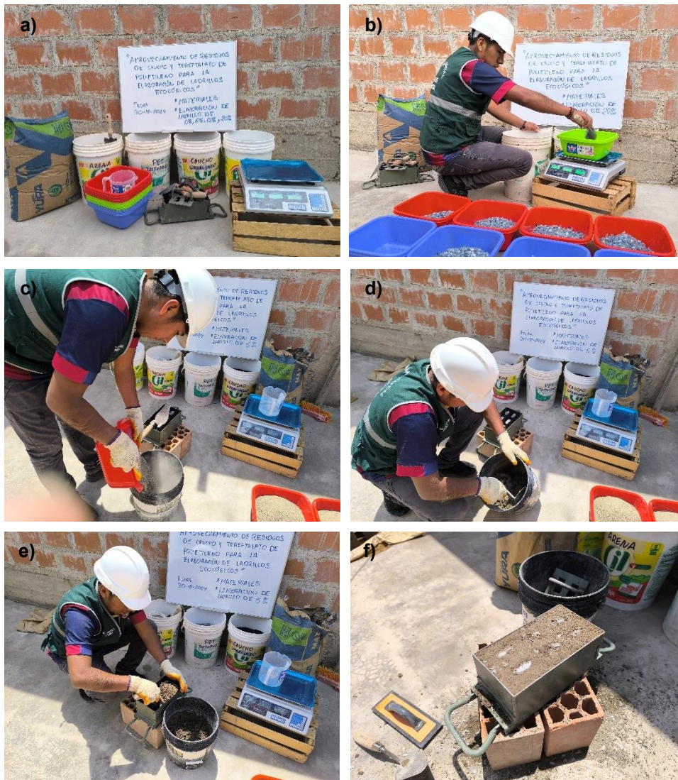
Fotografía 2. Preparación de material, dosificación y mezclado
