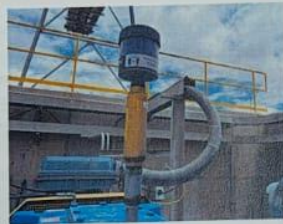
Figura 1 Reductores de velocidad de con trampa de vapor de aceite y filtro desecante Fuente: Propia
