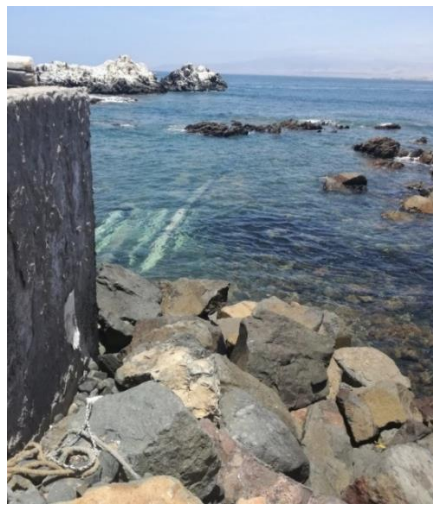
Figura 1. Tuberías en el fondo marino. Fuente: Elaboración propia
