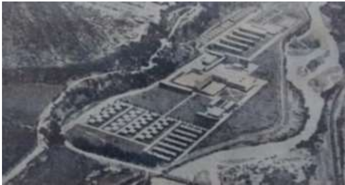
Fig. 40 - Vista aérea del CMSPP
