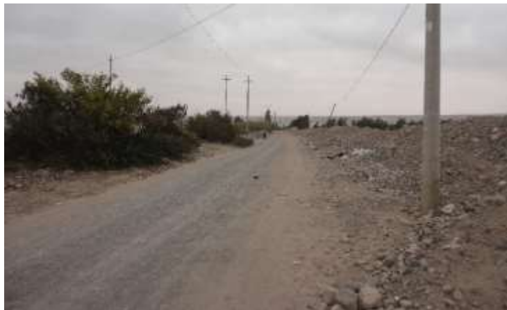
Fig. 83 - Vía Secundaria, av. Ciudadela, vía no consolidada. Fuente: Elaboracion Propia
