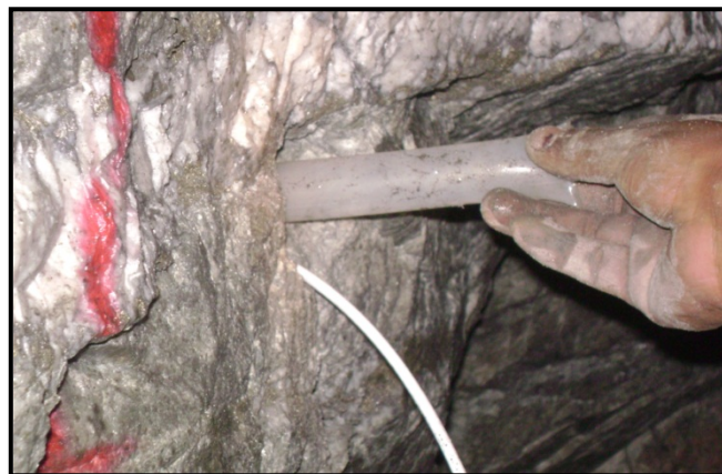
Figura 4.23.: Colocación de cojines de agua en los taladros de la corona.
