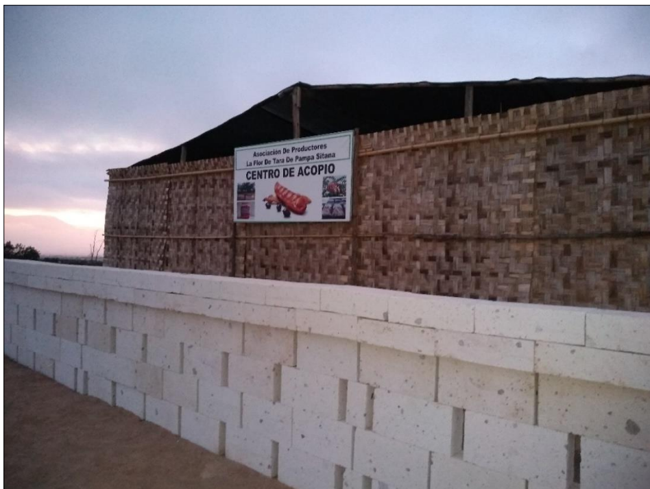
Figura 4. Instalación de Centro de Acopio de Tara de la APFTPS.
