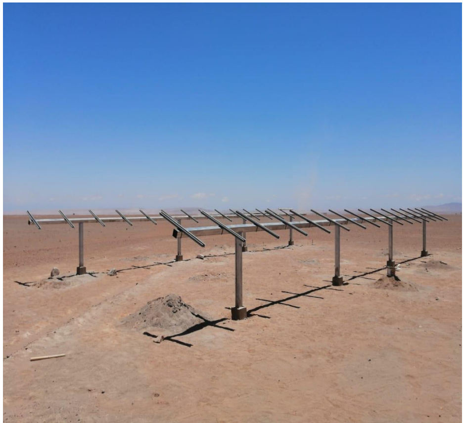
Figura 30 Fijación de omegas
