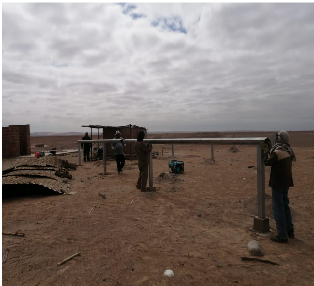
Figura 29 Fijación de vigas a los pilares
