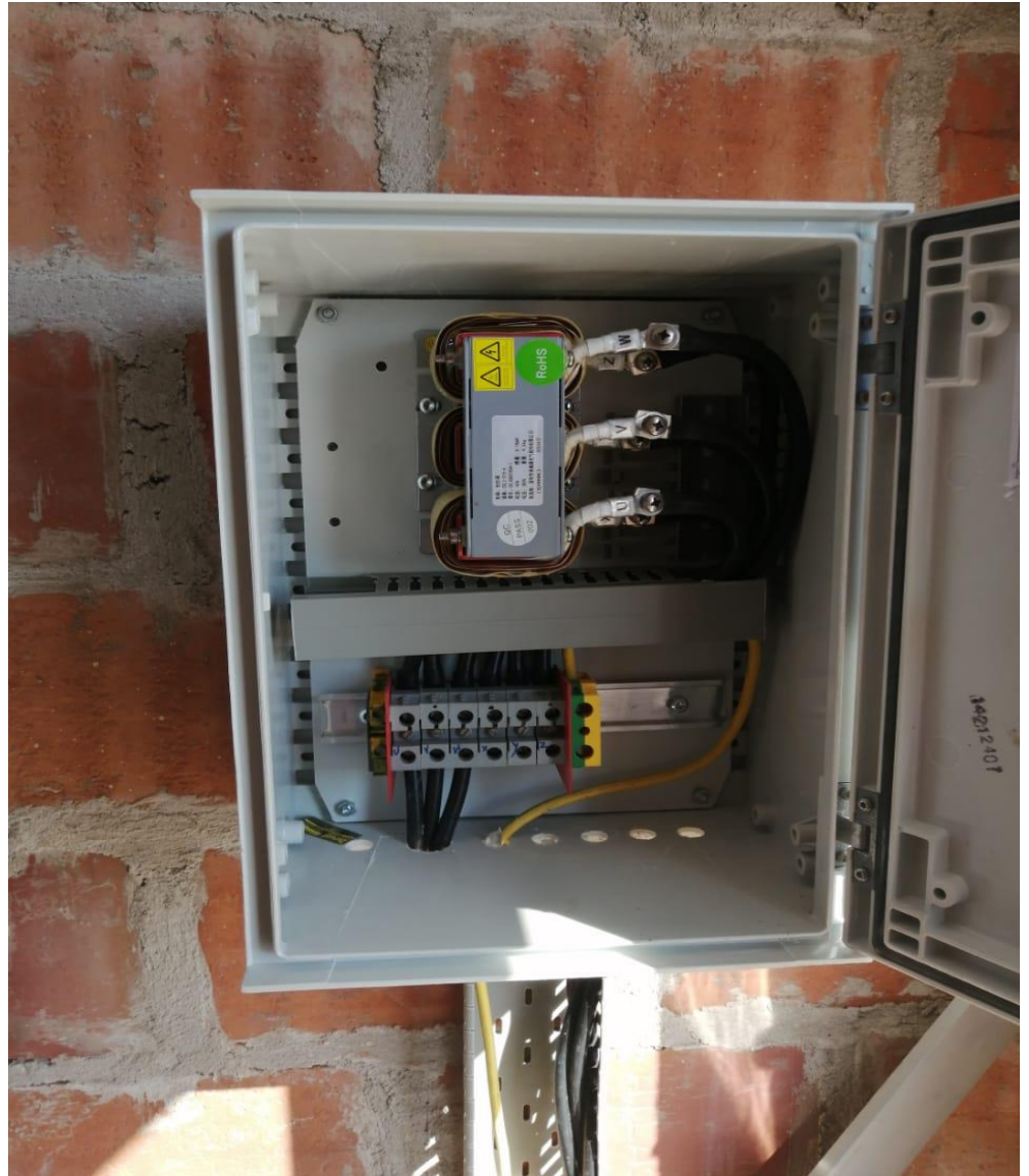
Figura 37 Instalación de filtro de armónicos
