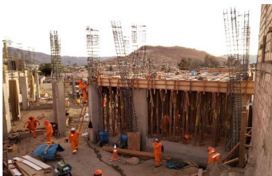
ENCOFRADO DE LOSA ALIGERADA SECTOR 01
