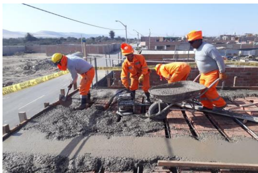
VACIADO DE LOSA CON CONCRETO f'c=210 kg/cm 2
