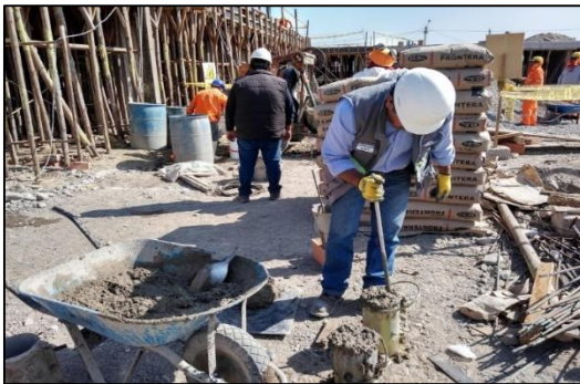
MUESTRAS PARA CONTROL RESISTENCIA CONCRETO
