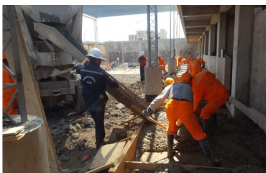
VACIADO DE VEREDAS
