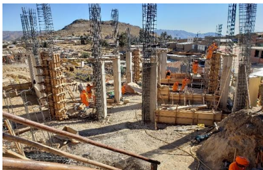
ENCOFRADO Y VACIADO DE COLUMNAS
