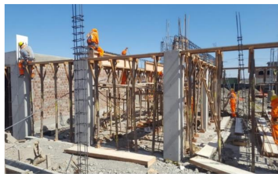
ENCOFRADO FONDO DE VIGA
