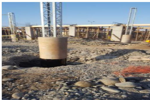
IZADO DE ESTRUCTURA METALICA EN COLUMNAS
