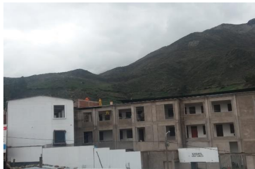
TARRAJEO INTERIOR Y EXTERIOR
