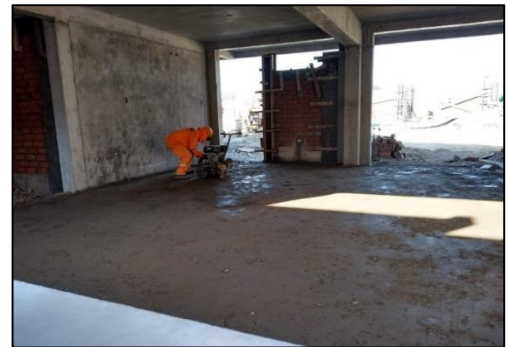
VACIADO FALSO PISO EN AULAS
