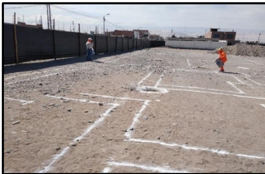
TRAZO Y REPLANTEO EN TERRENO
