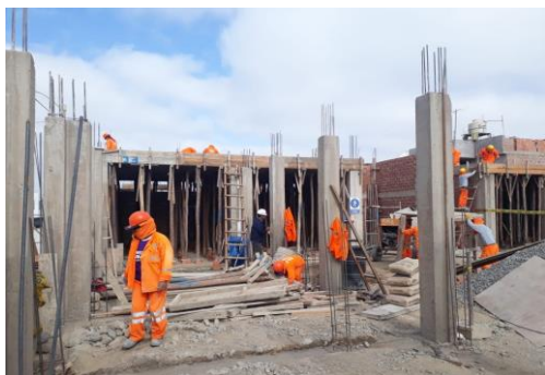
ENCOFRADO DE AMBIENTES
