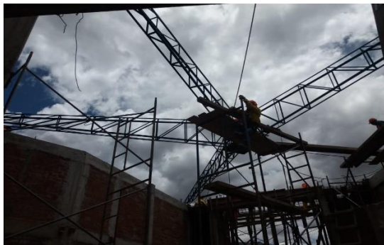
ESTRUCTURA METALICA COMO PROTECCION PATIO
