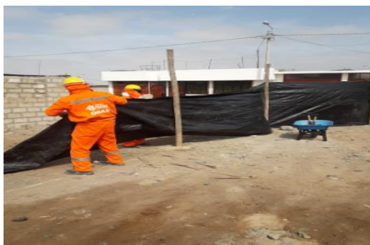
COLOCADO DE CERCO PERIMETRICO
