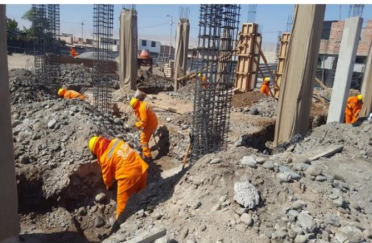
EXCAVACION DE SANJAS PARA CIMENTO CORRIDO
