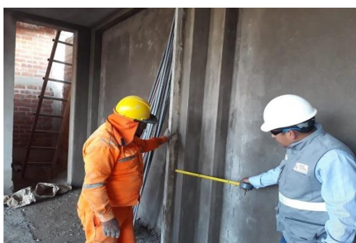
CONTROL TARRAJEO MUROS
