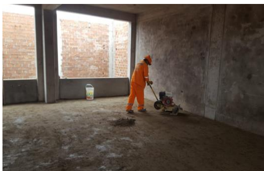
COMPACTADO DE FALSO PISO
