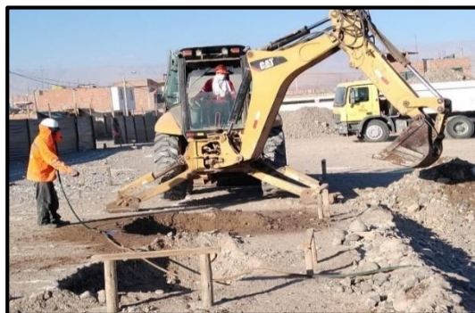
EXCAVACION DE SANJAS CON RETRO EXCAVADORA
