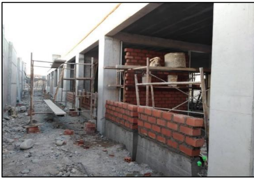
ASENTADO DE LADRILLO EN MUROS DE AULAS
