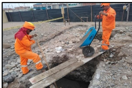
VACIADO DE CONCRETO EN SOLADO DE ZAPATAS
