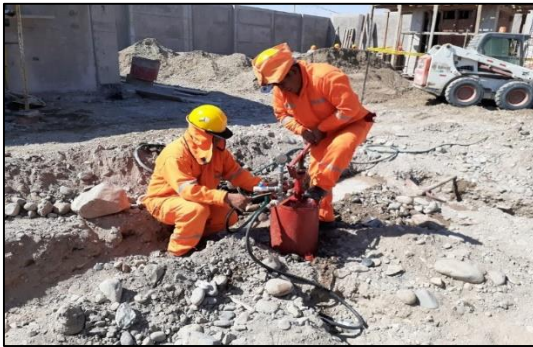
PRUEBA HIDRAULITA TUBERIAS DE AGUA
