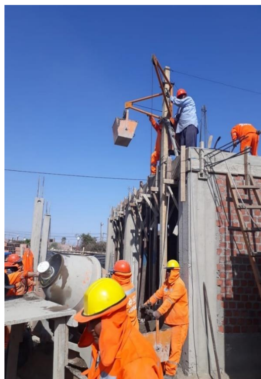
ENCOFRADO Y VACIADO DE LOSA ALIGERADA CON CONCRETO FC=210 KG/CM2
