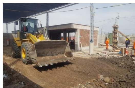
ELIMANACION DE MATERIAL EXCEDENTE
