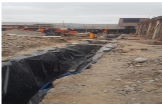
CIMENTACION CERCO CON PLASTICO DE PROTECCION
