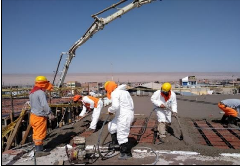
VACIADO DE LOSA CON BOMBA
