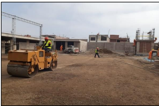
COMPACTADO DE PISO CON RODILLO EN PATIO
