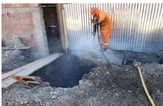
EXCAVACION CON MARTILLO NEUMATICO PARA CORTAR ROCA
