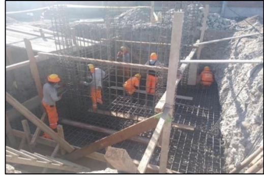
HABILITACION ACERO TANQUE CISTERNA
