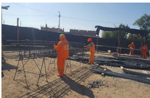
HABILITACION DE ACERO PARA COLUMNAS
