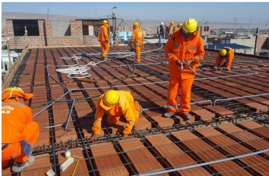
INSTALACIONES ELECTRICAS EN LOSA
