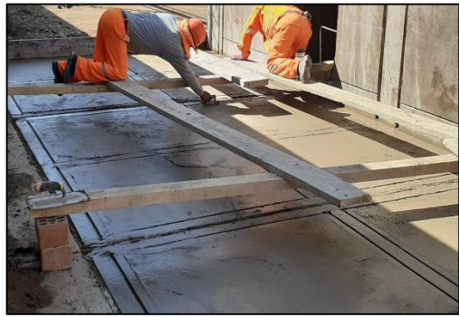
ACABADO PISO DE CEMENTO PULIDO
