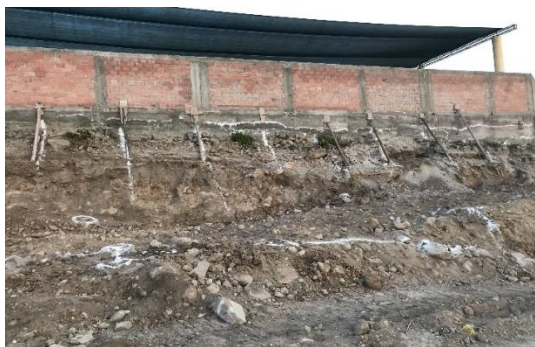
TRAZADO DE TERRENO DE ACUERDO AL PROYECTO CON EQUIPO TOPOGRAFICO
