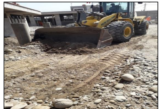
CORTE CON MAQUINARIA PATIO
