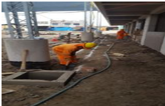
EXAVACION PARA INSLACIONES ELECTRICAS
