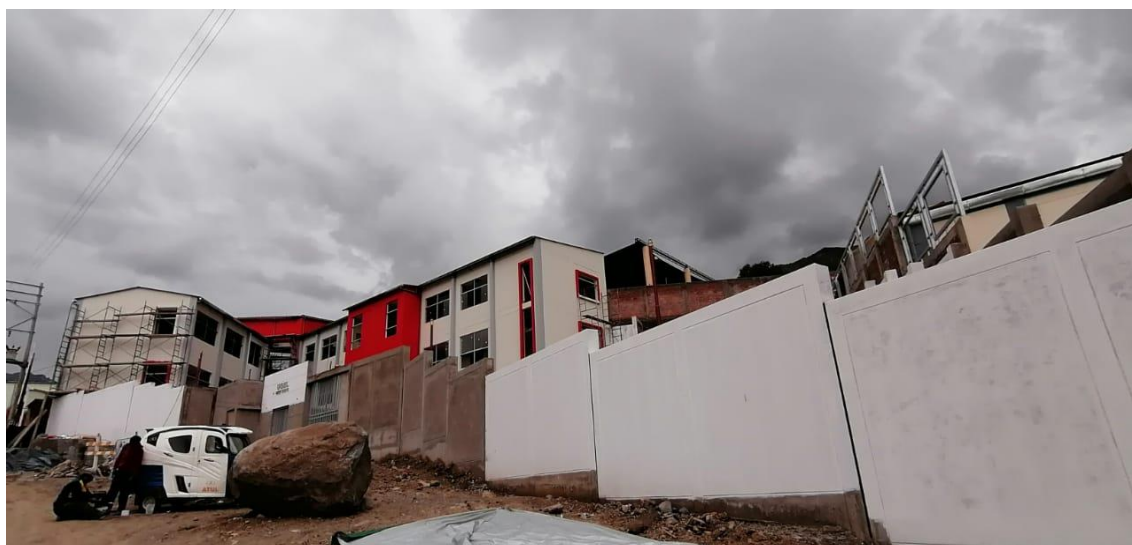
VISTA EXTERIOR DEL LOCAL CON BASE E INICIO DE PINTADO
