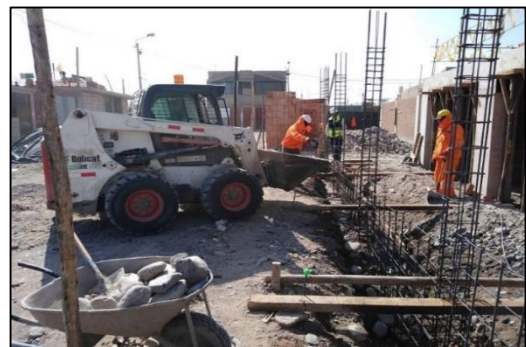
VACIADO DE CIMENTOS EN CERCO
