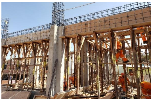
ENCOFRADO Y VACIADO DE COLUMNAS
