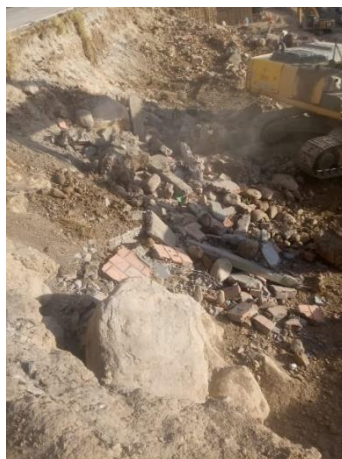
CORTE CON EXCAVADORA Y PERFILADO CON PERSONAL DE OBRA
