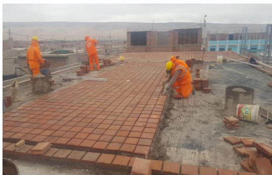
COLOCACION DE LADRILLO PASTELERO EN LOSA
