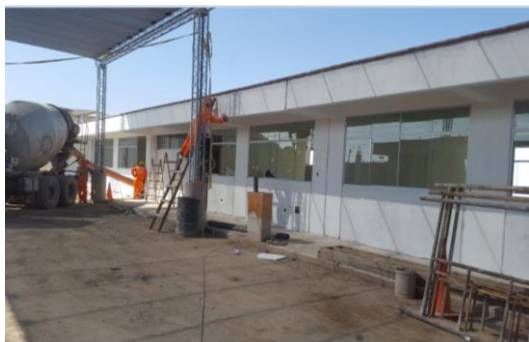
PINTURA EN EXTERIORES E INTERIORES Y COLOCACION DE VIDRIOS
