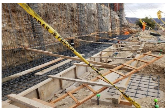
COLOCADO DE ACERO EN ZAPATAS Y MURO DE CONTENCIÓN
