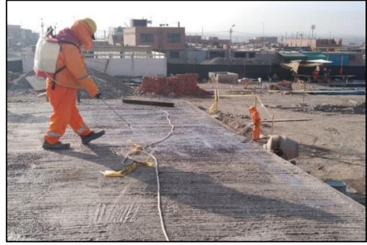
CURADO DE LOSA CON ADITIVO
