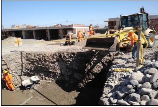
VACIADO SOLADO TANQUE CISTERNA
