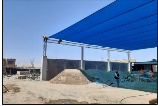
INSTALACION DE MALLA RACHELL EN PATIO
