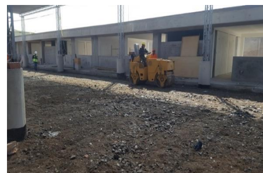
COMPACTADO DE PATIO
