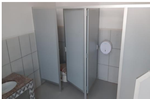
ACABADO DE DIVISIONES EN BAÑO
