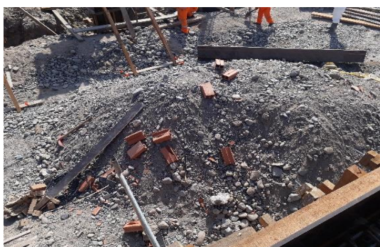
RESIDUOS DE MATERIALES (LADRILLO, PIEDRA, TIERRA, MADERA, TUBOS DE PLASTICO Y CLAVOS)
