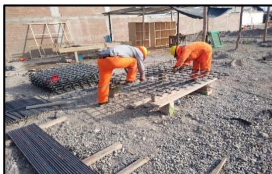
HABILITACION DE PARRILLAS PARA ZAPATA
