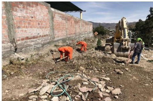
TRABAJOS PRELIMINARES DE OBRA
