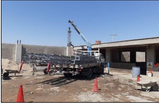
IZADO CON GRUA COLUMNAS METALICAS
