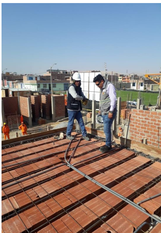
ENCOFRADO Y VACIADO DE LOSA ALIGERADA CON CONCRETO FC=210 KG/CM2
