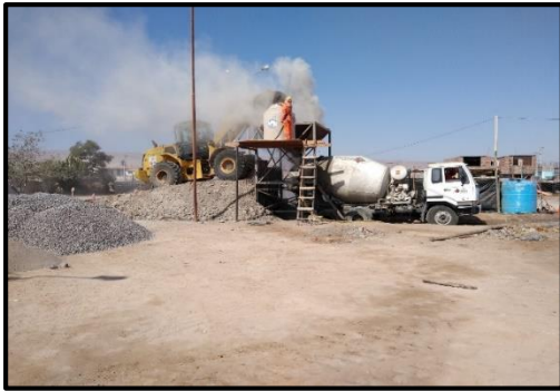
PREPARACION DE CONCRETO
