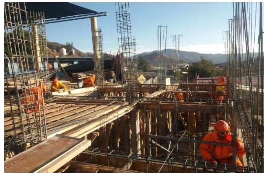
ENCOFRADO SEGUNDO NIVEL
