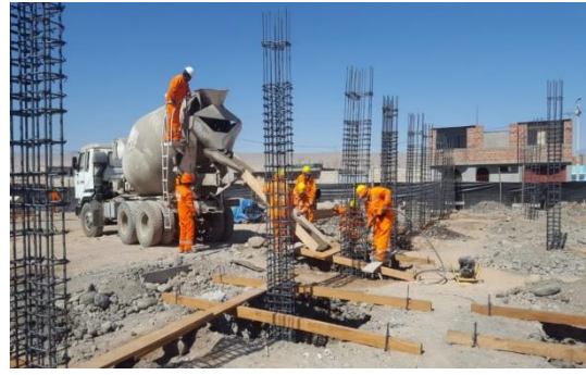
VACIADO ZAPATAS CON MIXER
