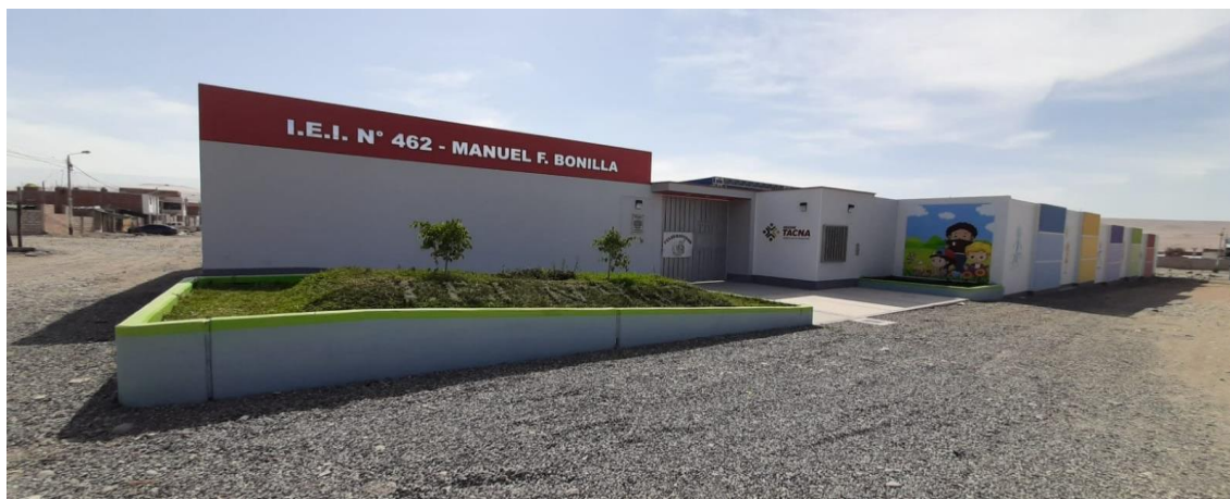
VISTA DE LA FACHADA CULMINADA
