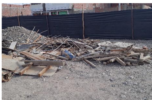
MEZCLA DE RESIDUOS DE MADERA Y AGREGADOS
