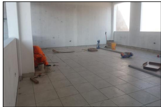
ASENTADO PISO DE PORCELANATO - AULAS
