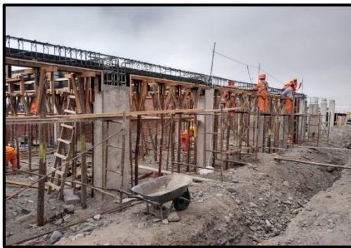
ENCOFRADO FONDO DE VIGA
