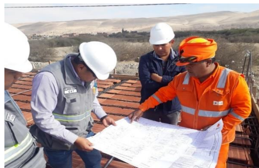
REVISION DE ENCOFRADO DE LOSA CON PLANOS
