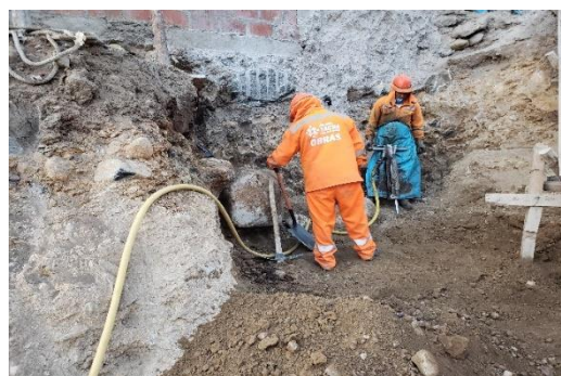
EXCAVACION CON MARTILLO NEUMATICO PARA CORTAR ROCA
