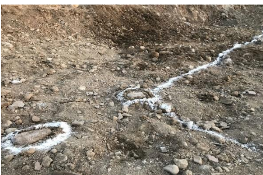
TRAZADO DE TERRENO DE ACUERDO AL PROYECTO CON EQUIPO TOPOGRAFICO
