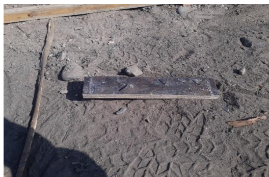
PELIGROS PARA LA INTEGRIDAD DE LOS TRABAJADORES
