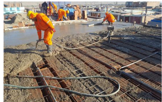
VACIADO DE LOSA ALIGERADA CON CONCRETO FC=210 KG/CM2
