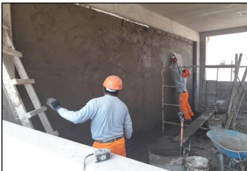
TARRAJEO MUROS INTERIORES
