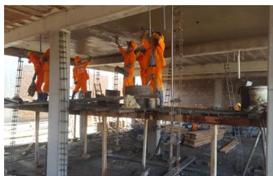
TARRAJEO DE TECHO
