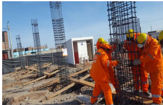
IZADO DE ACERO PARA COLUMNAS
