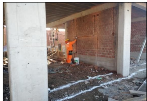
CORTE MUROS - INSTALACIONES ELECTRICAS
