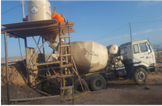
HABILITACION DE AGREGADO Y AGUA A MIXER
