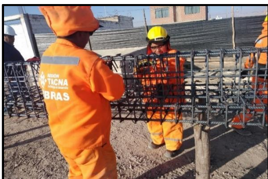
HABILITACION ACERO PARA COLUMNAS
