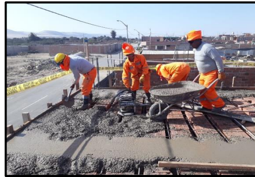
VACIADO DE LOSA ALIGERADA
