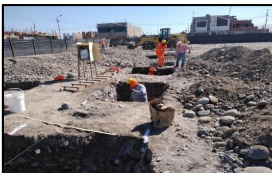
EXCAVACION DE ZAPATAS
