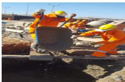
VACIADO DE SOLADO
