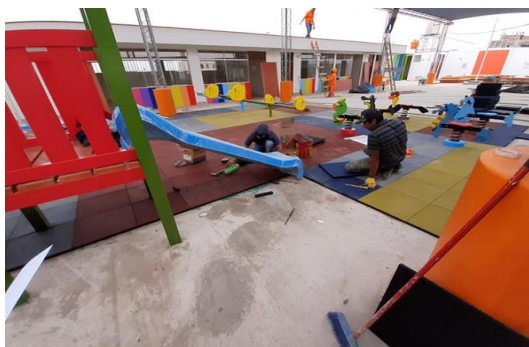
COLOCACION DE PISO DE CAUCHO – ZONA JUEGOS SEMBRADO DE ARBUTOS EN JARDINERAS
