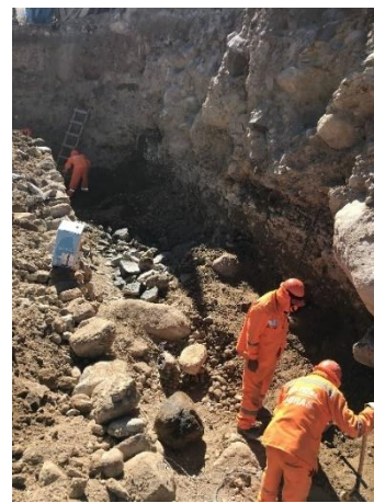
CORTE CON EXCAVADORA Y PERFILADO CON PERSONAL DE OBRA
