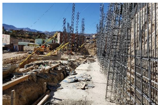
COLOCADO DE ACERO EN ZAPATAS Y MURO DE CONTENCIÓN
