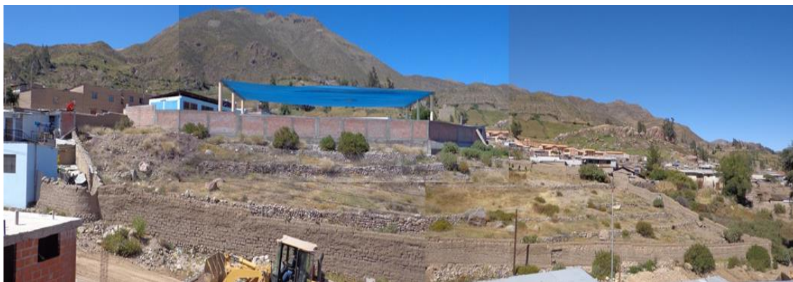
INGRESO POR LA CALLE PRIMERO DE SETIEMBRE
