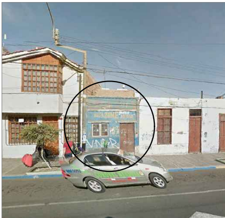
VIVIENDA MAL-ESTADO-AV. DOS DE MAYO
