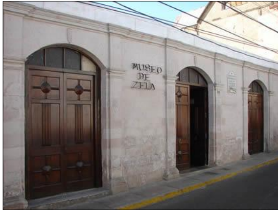
Figura 5. Fachada de la Casa Zela
