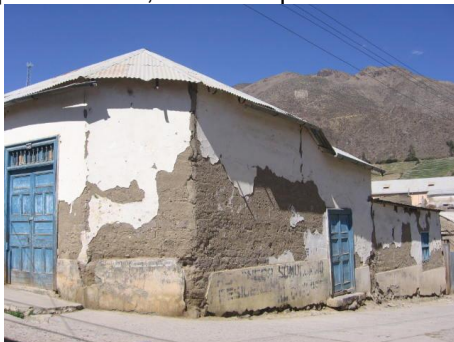
Remate de la calle Ticaco, esquina con la prolongación de la calle Ramón Copaja, camino hacia la plaza, donde destaca el inmueble de características tradicionales que amerita la recuperación a través de los resanes y restitución de revocos.
