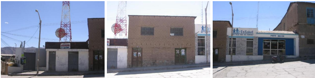
Frente de la plaza hacia la calle Bolognesi, donde se distingue un local de la telefónica, vivienda y local de Essalud.
