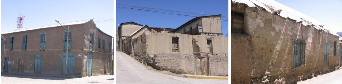
Inmueble ubicado entre las calles Bolognesi y Ramón Copaja, material de adobe y quincha, vista desde el frente y parte posterior, se observa una distribución en U en torno a un patio central. Interiormente se distingue un balcón corrido.
