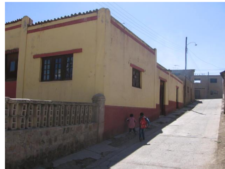
Intersección de las calles Ramón Copaja y la calle 1ro de septiembre, donde se denota una arquitectura de los años 40, y la intromisión de un cerco de nivel bajo, predominando el uso de jardines en retiro, se presentan condiciones contractivas a mejorar
