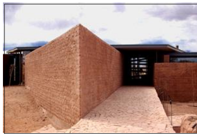
FIGURA 8. VISTA INGRESO RESTAURANT
