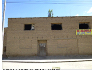
FIGURA 2. VIVIENDA EN MAL ESTADO
