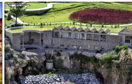
FIGURA 11. VISTA EXTERIOR SPA
