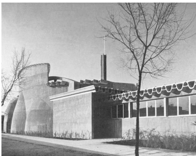
IMAGEN N°12: Fachada posterior y ábside.
