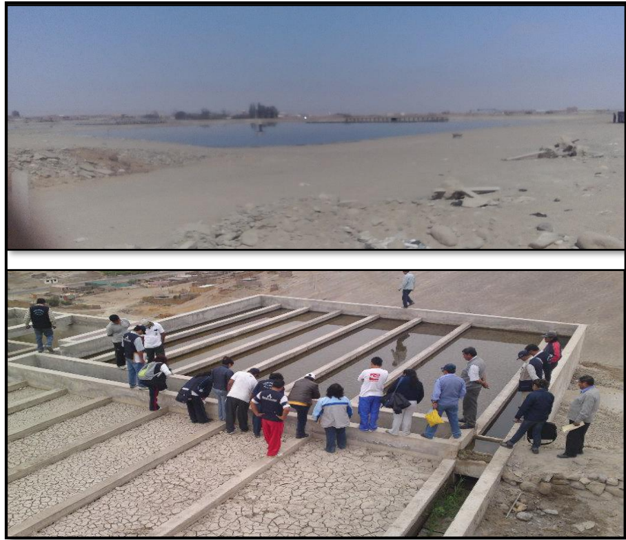
Figura 41. Planta de tratamiento de aguas residuales, principal foco de contaminación.
