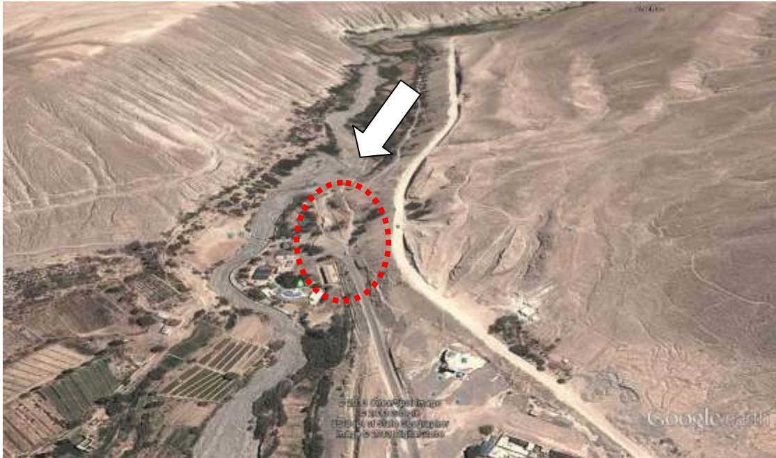
Figura 32 Bocatoma Calientes y Baños Termales
