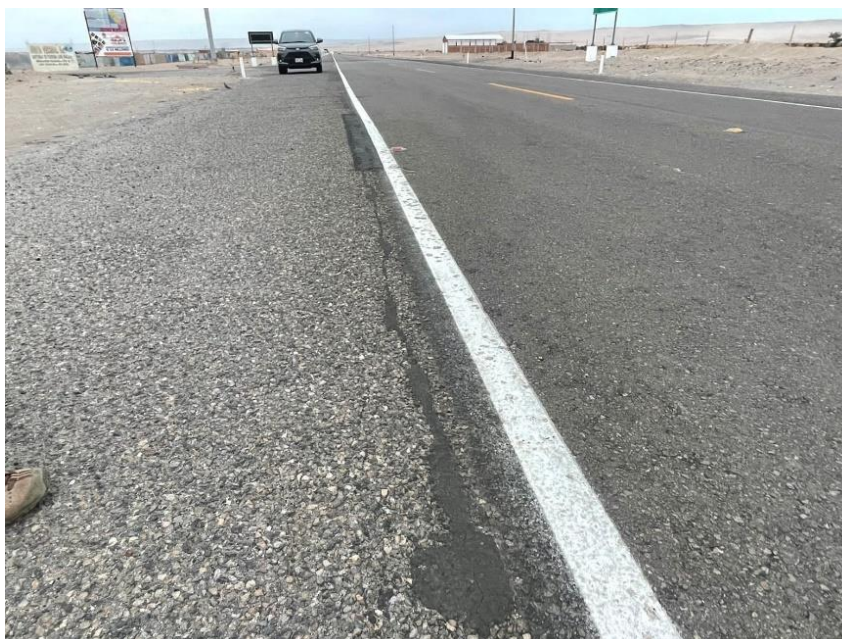
Fotografía 7. Fallas tipo parcheo en el pavimento encontradas en la vía PE-1S, sección de muestra Km 133+294 – UMA 277.
