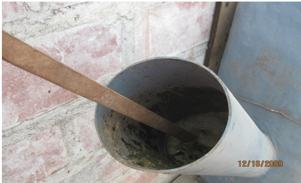
ANEXO 18: Final de la carga al Biodigestor
