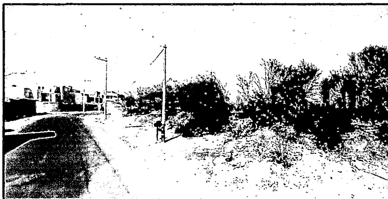
Foto 43 - Poste de Telefonía y Comunicaciones.
