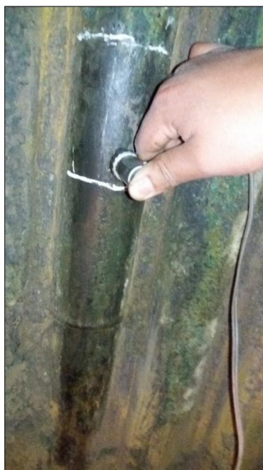
Figura 27. Medición de espesores por ultrasonido
