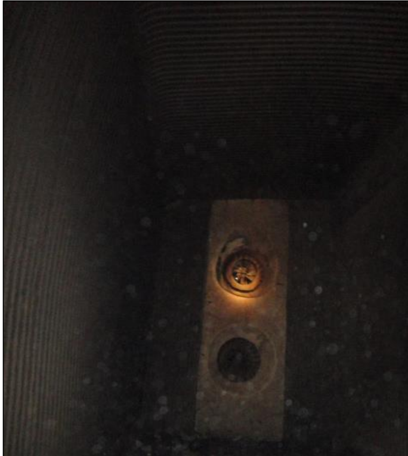
Figura 24. Hogar de la Caldera N° 4
