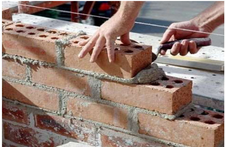
Figura 45 Construcción con ladrillo
