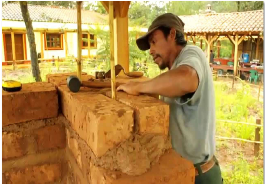
Figura 44 Construcción con adobe
