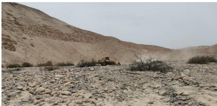
Figura 10. Desbroce de la zona a explotar de la C.M. Karlita
