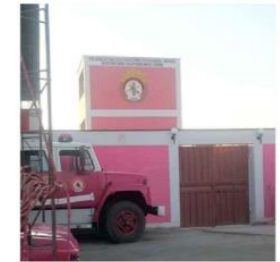
VISTA TORRE DE ESCALERA
