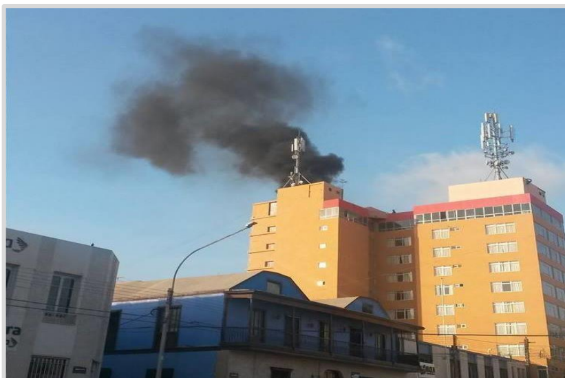
Figura N° 17 Incendio – Hotel Emperador
