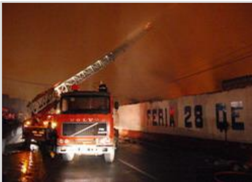
Figura N° 16 Incendio – Feria 28 de Julio
