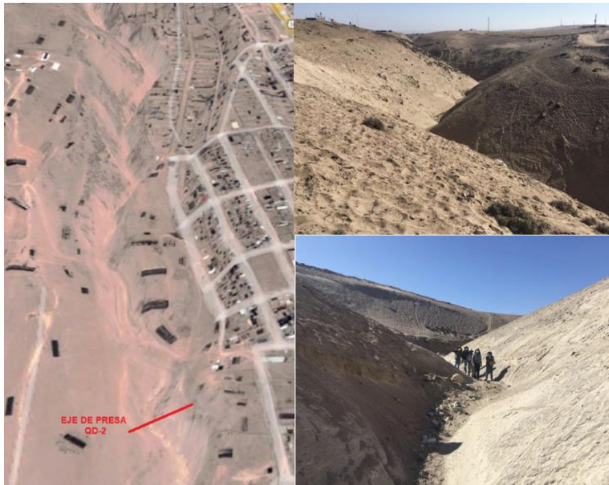
Figura 32. Vista del eje de la presa QD-2 de control de huaicos y el vaso de almacenamiento de sólidos
