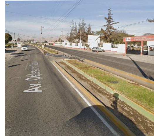
Carretera Tacna Collpa – La Paz
