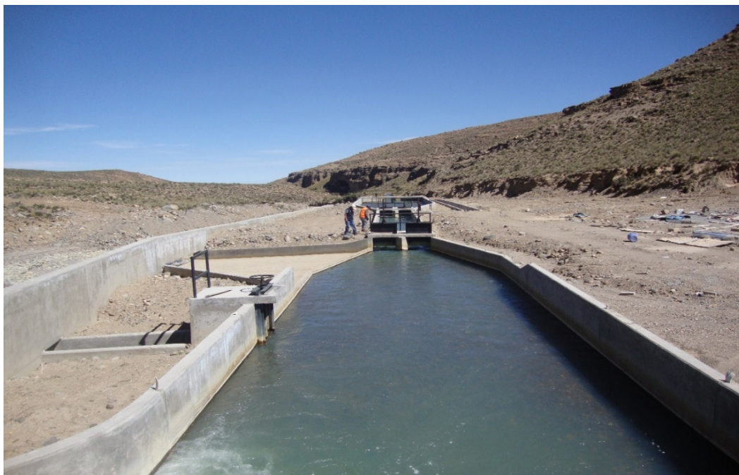
Vista panorámica: Infraestructura hidráulica, bocatoma Coranchay – río Callazas – a 3900 msnm. Se capturaron un promedio de 1150 L/S. de agua para riego por gravedad, en los distritos de Cairani, Candarave, Huanuara y Quilahuani.
