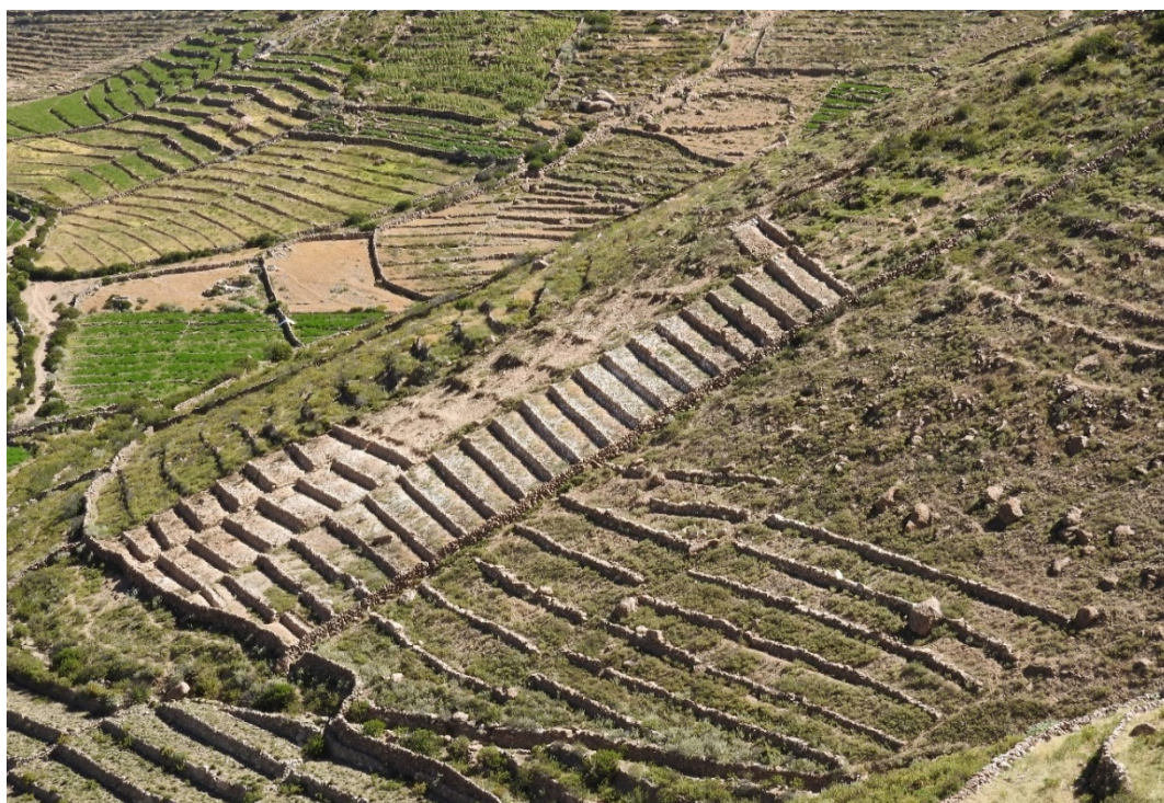
Vista panorámica: Conservación y manejo de suelos y agua en sistema de andenería, con prácticas agronómicas (rotación de cultivos) y prácticas mecánicas estructurales (acequias, reservorios y otros).
