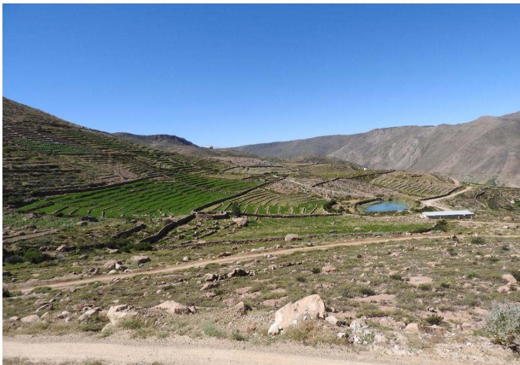
Vista panorámica: Infraestructura de riego, reservorio utilizado para almacenar agua por las noches y para el riego por gravedad durante el día, con el propósito de lograr la eficiencia del riego.
