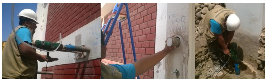
Figura 3. 4: Extracción de núcleos de concreto con equipo diamantado.
