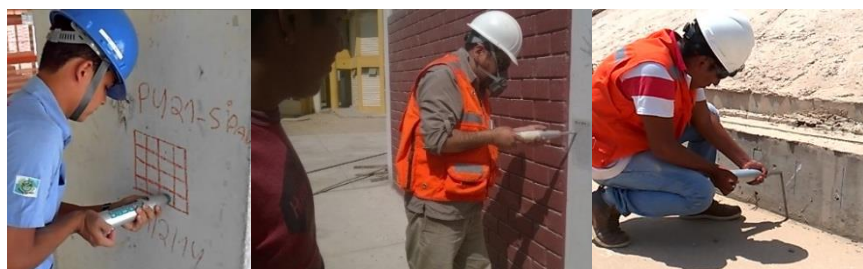
Figura 3. 3: Ensayo con Esclerómetro en columnas y vigas.
