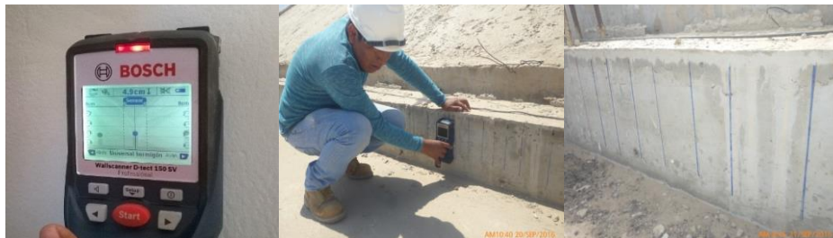
Figura 3. 2: Uso de equipo detector Wall-Scanner DT-150 Bosch. Fuente: Elaboración propia, 2 017.
