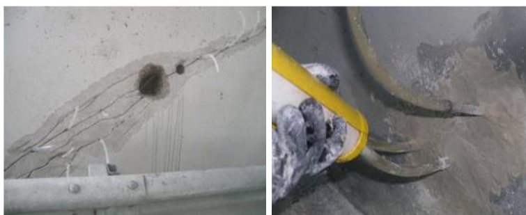
Figura 2. 21: Inyección de una fisura con resinas. Fuente: Sika.
