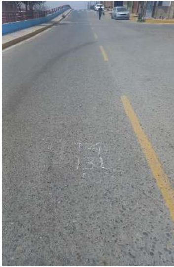
Unidad de muestreo U4 hueco de severidad leve
