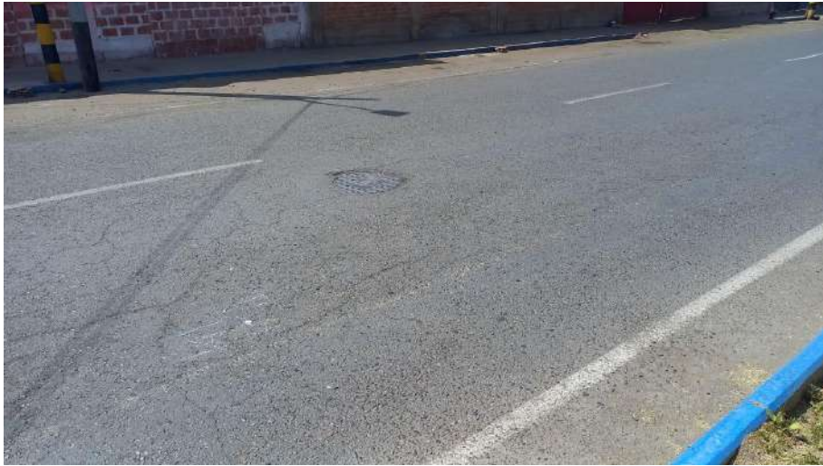
Unidad de muestreo U54 piel de cocodrilo de severidad media
