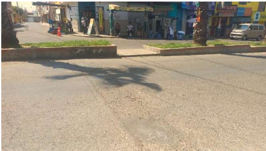
Unidad de muestreo U40 parcheo de severidad media
