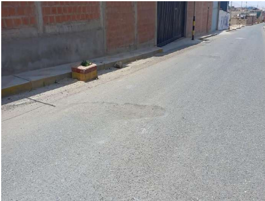
Unidad de muestreo U9 parcheo de severidad alta
