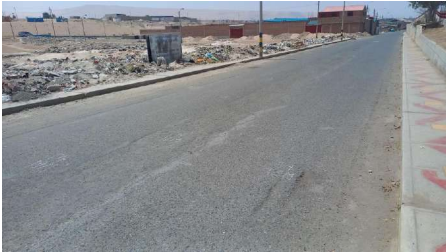
Unidad de muestreo U4 huecos de severidad media
