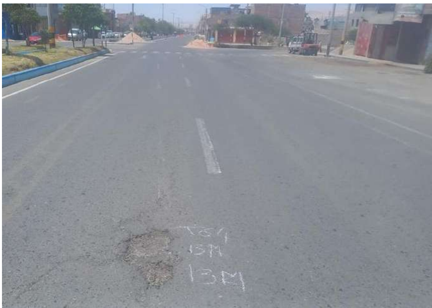
Unidad de muestreo U64 huecos de media severidad
