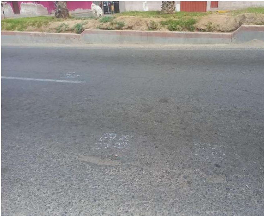
Unidad de muestreo U53 huecos de severidad media
