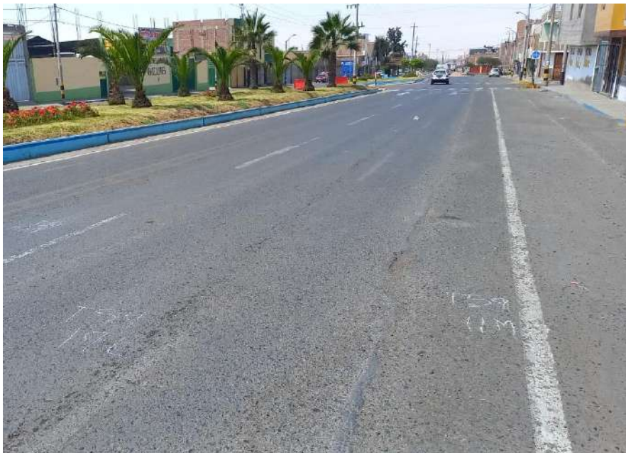
Unidad de muestreo U59 parcheo de severidad media
