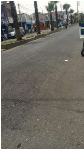
Unidad de muestreo U40 piel de cocodrilo de severidad media
