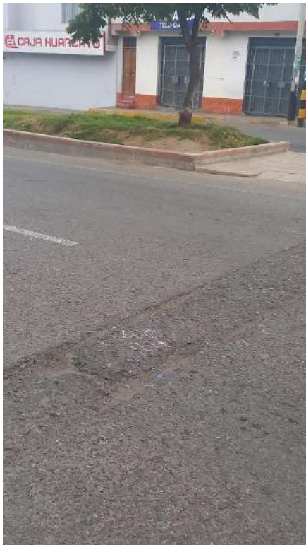
Unidad de muestreo U48 parqueo de severidad alta
