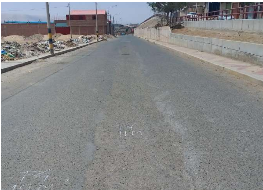
Unidad de muestreo U4 parcheo de severidad media
