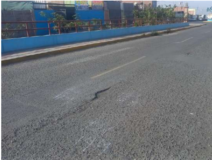
Unidad de muestreo U29 huecos de severidad media
