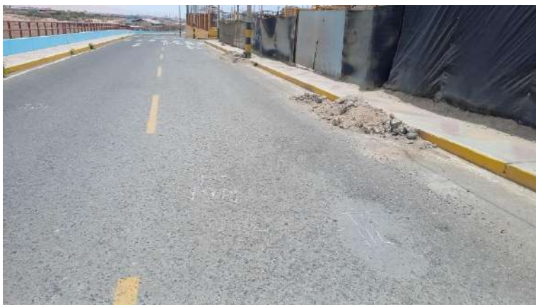
Unidad de muestreo U9 parcheo de severidad leve
