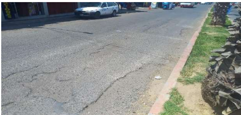
Unidad de muestreo U39 huecos de severidad alta
