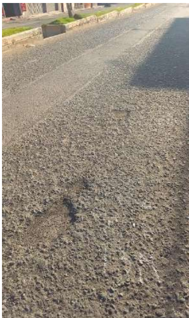
Unidad de muestreo U12 huecos de media y baja severidad
