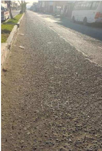
Unidad de muestreo U12 meteorización de agregados de media severidad y alta severidad
