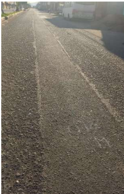
Unidad de muestreo U12 parcheo de media severidad
