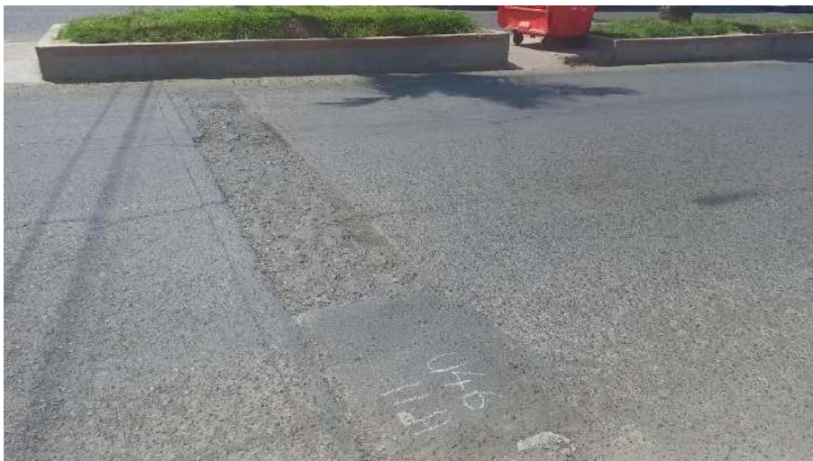
Unidad de muestreo U46 parcheo severidad alta
