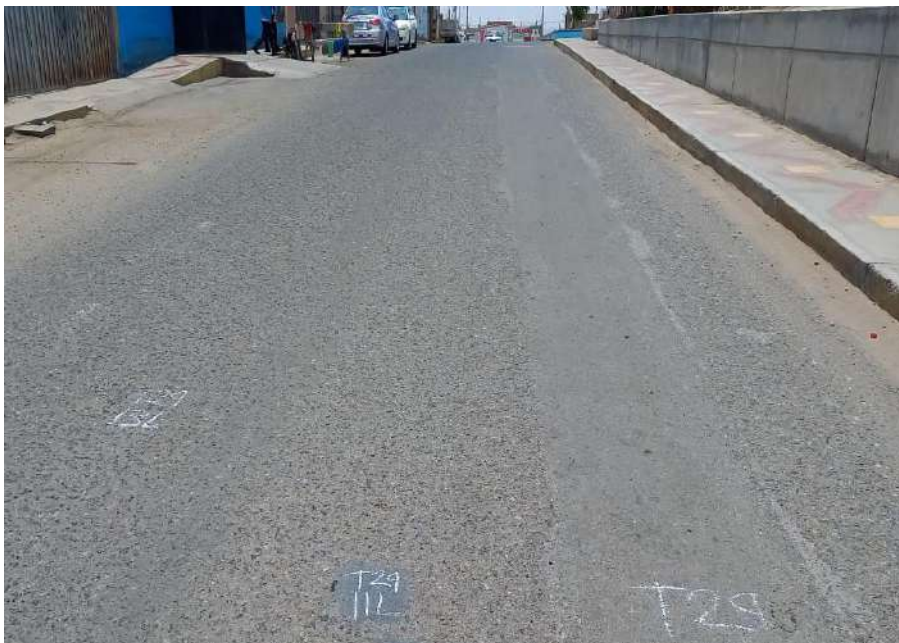
Unidad de muestreo U29 parcheo y hueco de severidad leve
