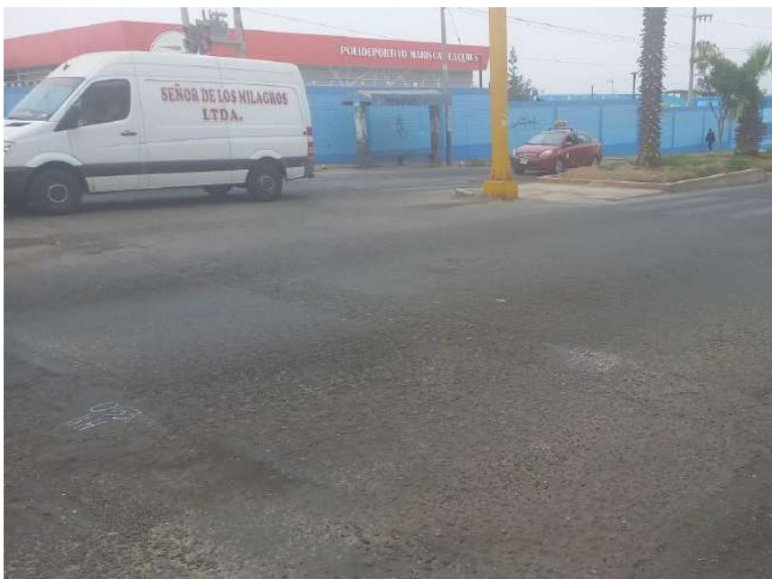
Unidad de muestreo U53 parcheo de alta y media severidad
