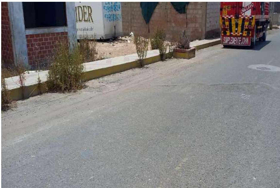
Unidad de muestreo U14 parcheo de media severidad
