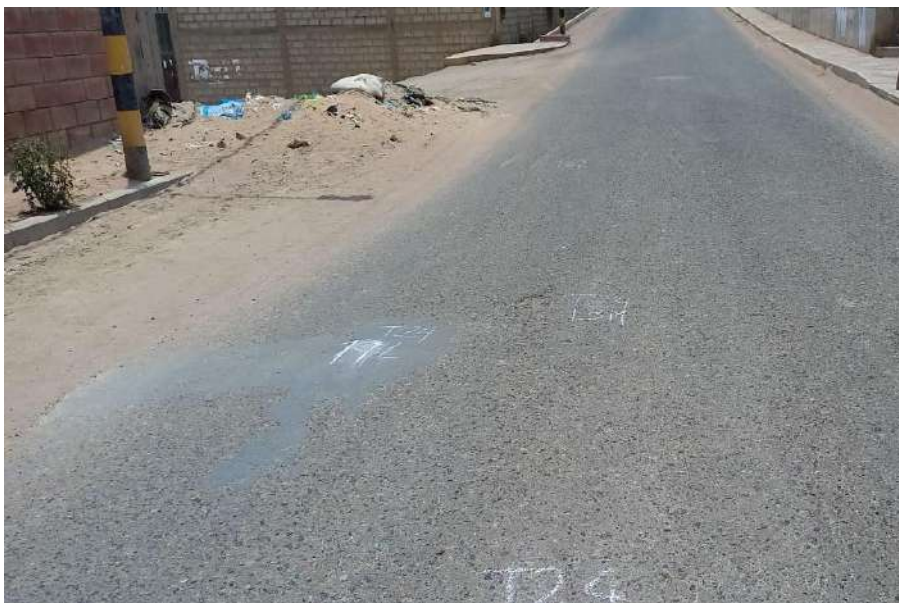
Unidad de muestreo U24 parcheo de severidad media y hueco de severidad media
