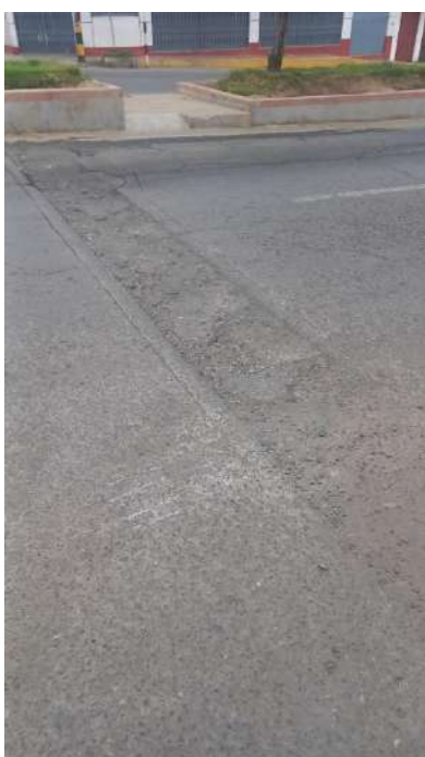
Unidad de muestreo U48 parcheo de severidad alta
