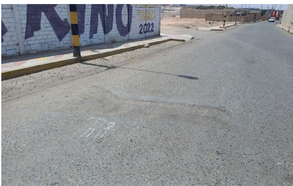
Unidad de muestreo U12 parcheo de alta severidad
