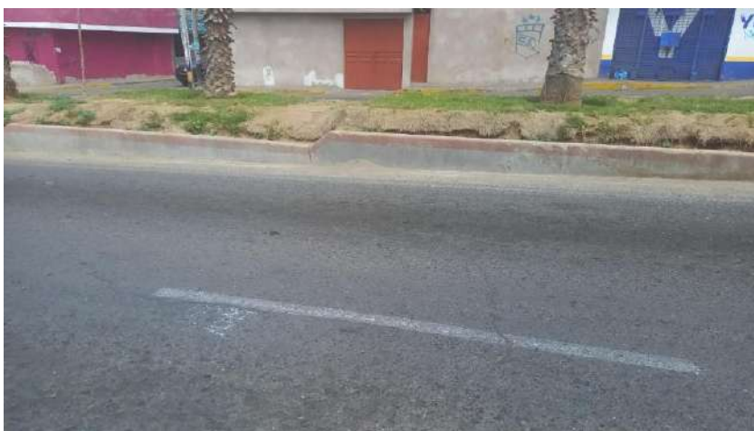
Unidad de muestreo U53 fisuras de severidad media
