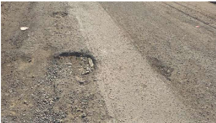
Unidad de muestreo U4 huecos de alta y mediana severidad
