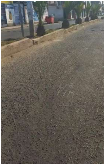
Unidad de muestreo U8 parcheo de severidad media
