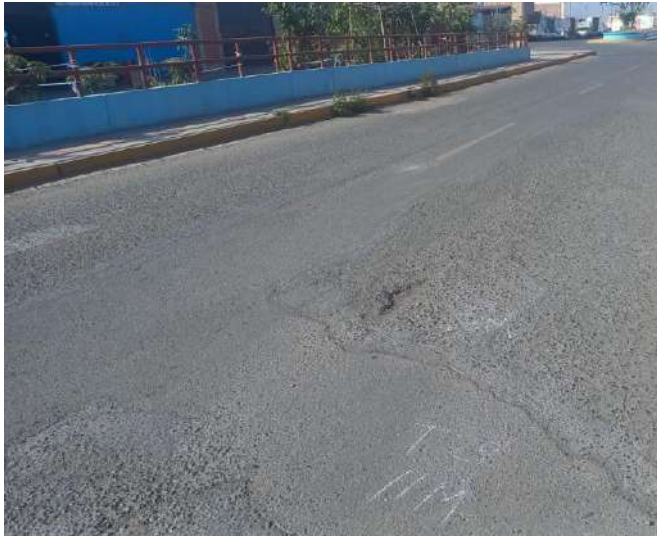
Unidad de muestreo U29 hueco y parcheo de severidad media
