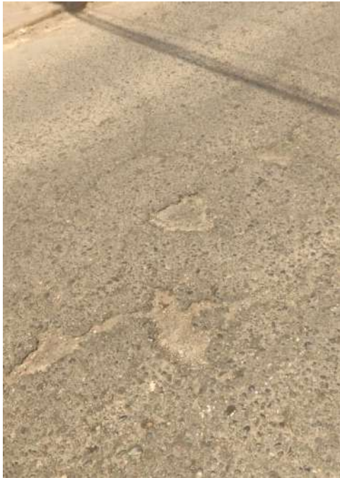
Unidad de muestreo U36 huecos de media severidad
