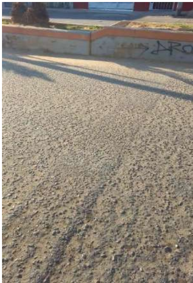
Unidad de muestreo U8 parcheo de media severidad
