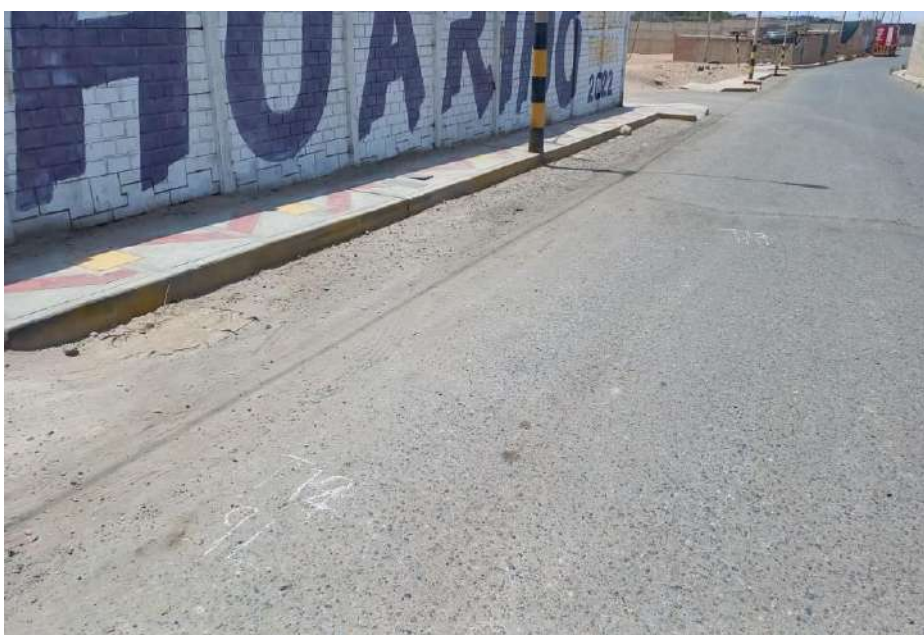
Unidad de muestreo U12 desnivel de carril berma de severidad leve
