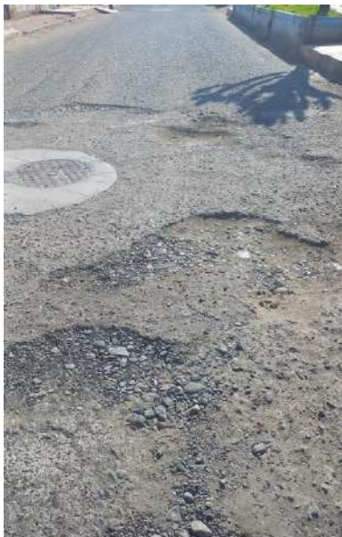
Unidad de muestreo U3 huecos de severidad alta
