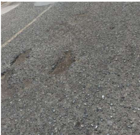
Unidad de muestreo U20 huecos severidad media
