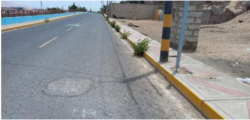
Unidad de muestreo U14 parcheo de severidad media
