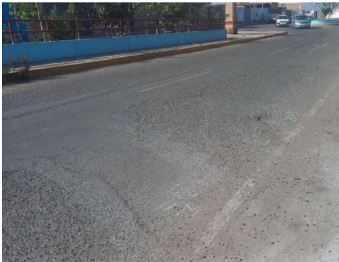
Unidad de muestreo U29 parcheo y huecos de severidad media
