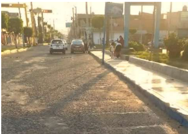
Unidad de muestreo U24 parcheo de severidad leve y meteorización de agregados de media severidad
