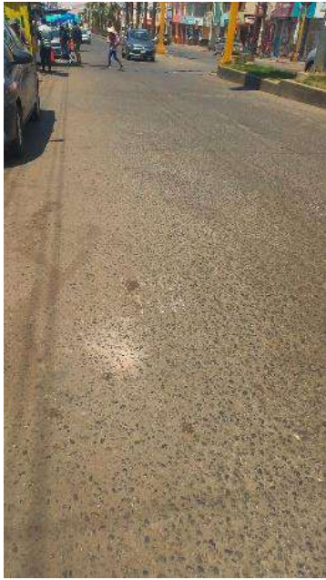
Unidad de muestreo U40 meteorización de agregados de alta y media severidad
