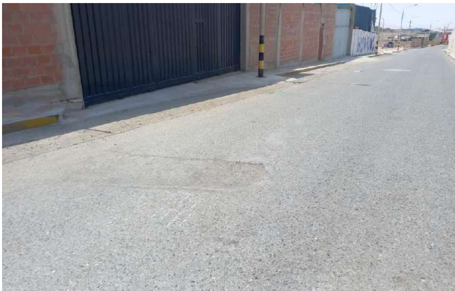
Unidad de muestreo U9 parcheo de alta severidad
