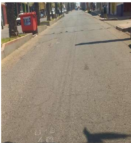
Unidad de muestreo U36 piel de cocodrilo de media severidad
