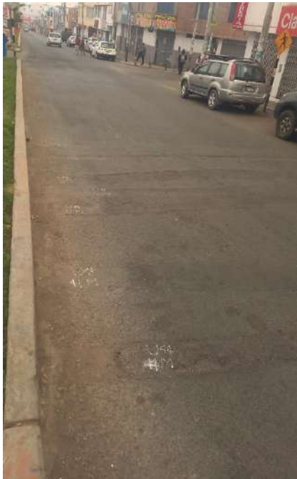
Unidad de muestreo U44 parcheo de severidad media
