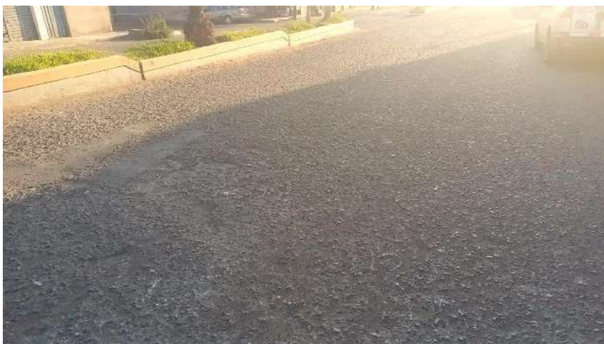
Unidad de muestreo U20 huecos de severidad media y parcheo de severidad leve
