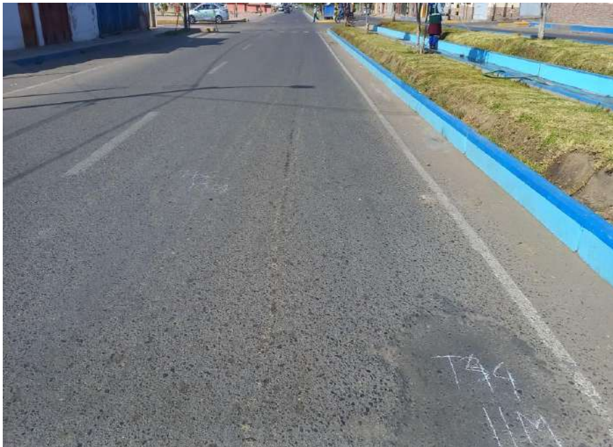
Unidad de muestreo U44 parcheo de severidad media
