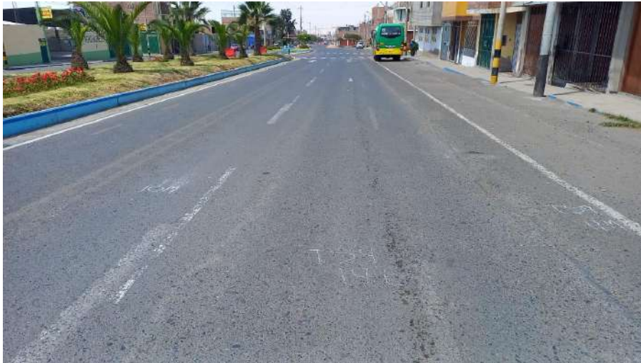
Unidad de muestreo U59 meteorización de agregados y fisura de severidad media
