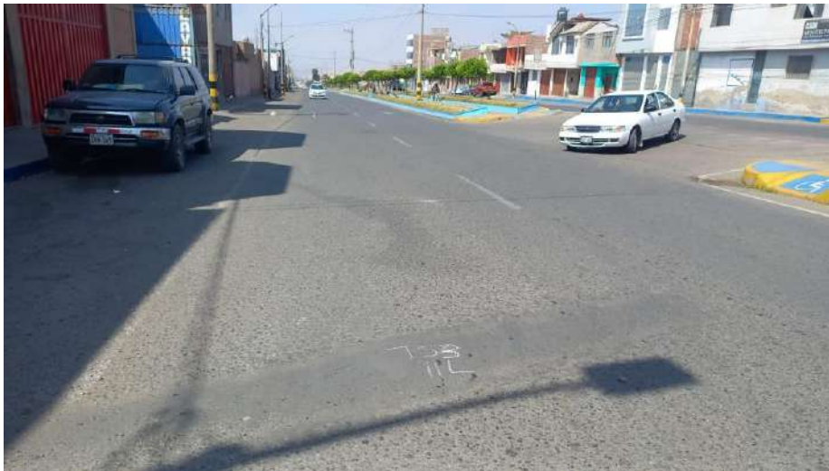
Unidad de muestreo U53 parcheo de severidad leve
