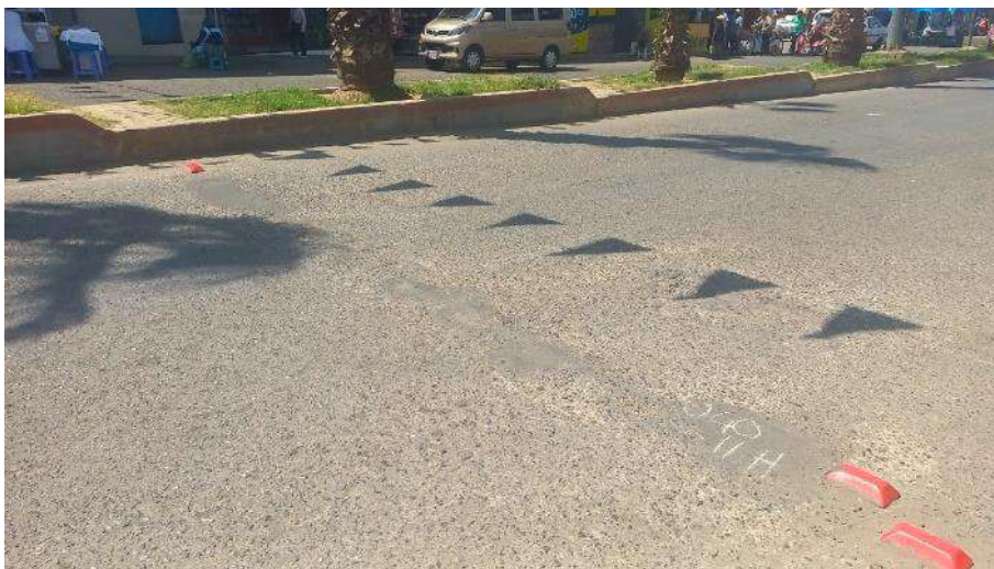
Unidad de muestreo U40 parcheo de severidad leve
