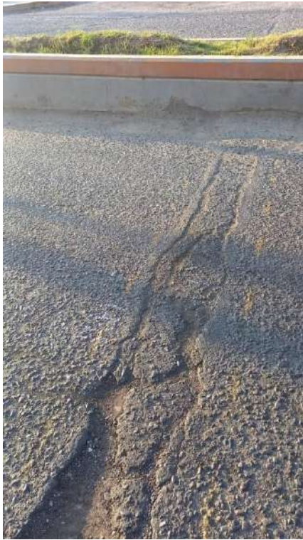
Unidad de muestreo U22 parcheo de severidad alta
