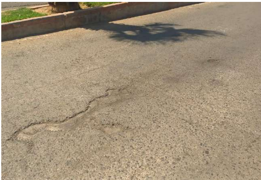
Unidad de muestreo U36 hueco de severidad media
