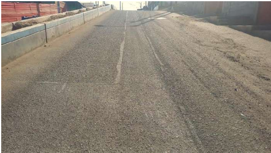
Unidad de muestreo U6 parcheo de severidad media
