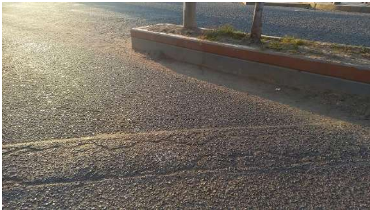
Unidad de muestreo U22 parcheo de severidad media
