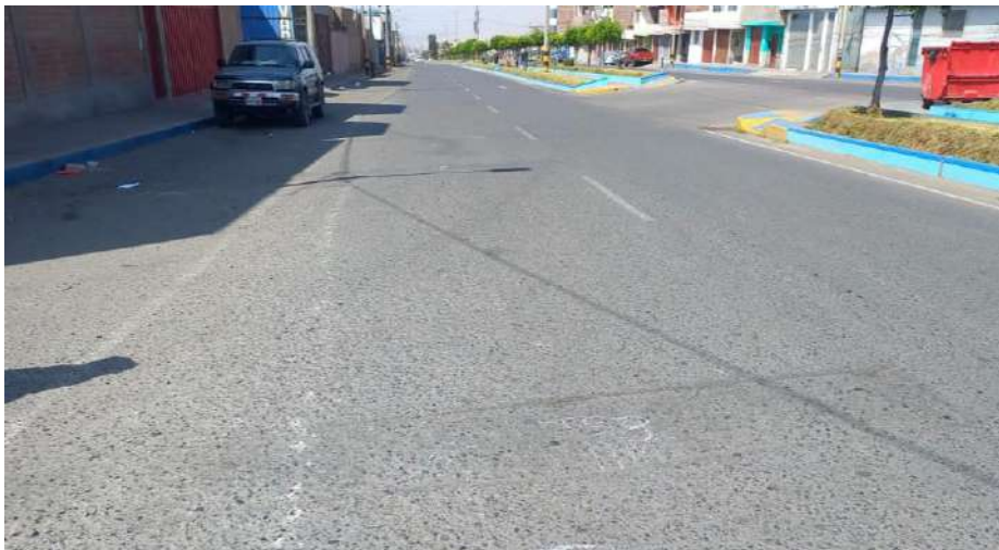
Unidad de muestreo U53 parcheo de severidad media
