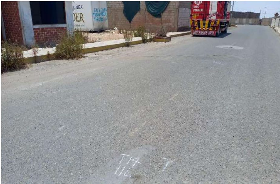
Unidad de muestreo U14 parcheo de severidad leve
