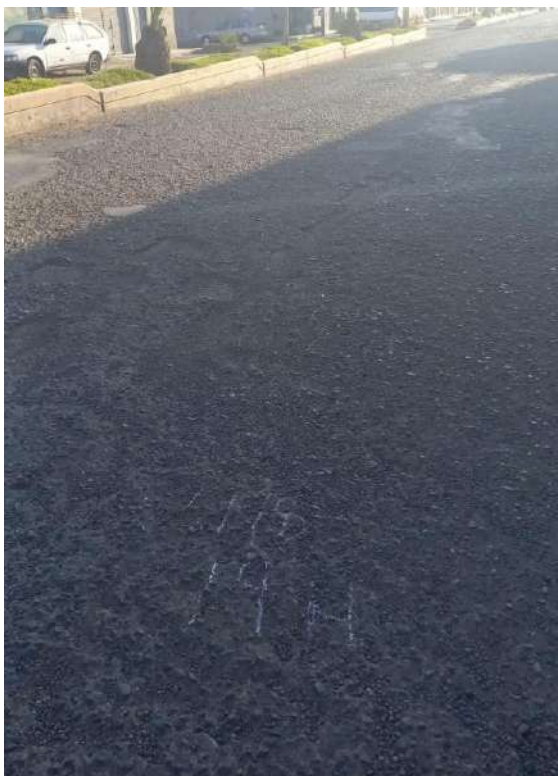
Unidad de muestreo U6 meteorización de agregados de media y alta severidad
