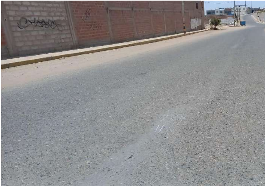
Unidad de muestreo U19 parcheo de severidad leve
