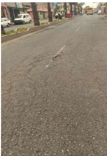
Unidad de muestreo U36 piel de cocodrilo de severidad alta
