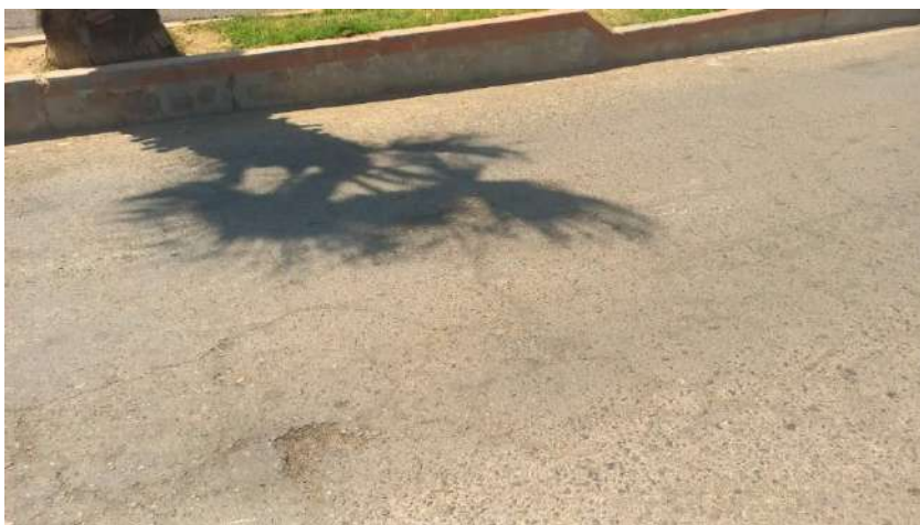
Unidad de muestreo U36 piel de cocodrilo de severidad media
