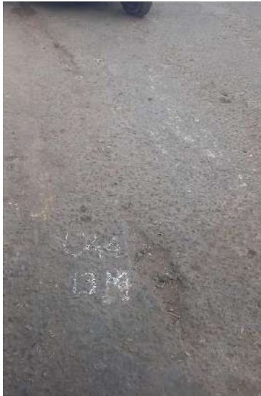
Unidad de muestreo U44 huecos de severidad media
