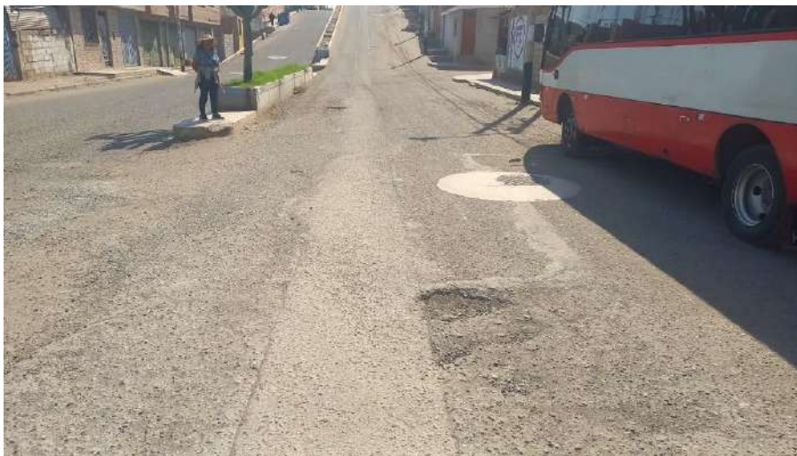
Unidad de muestreo U4 parcheo y hueco de severidad media
