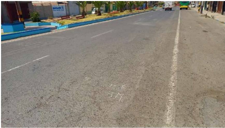
Unidad de muestreo U58 piel de cocodrilo de severidad media
