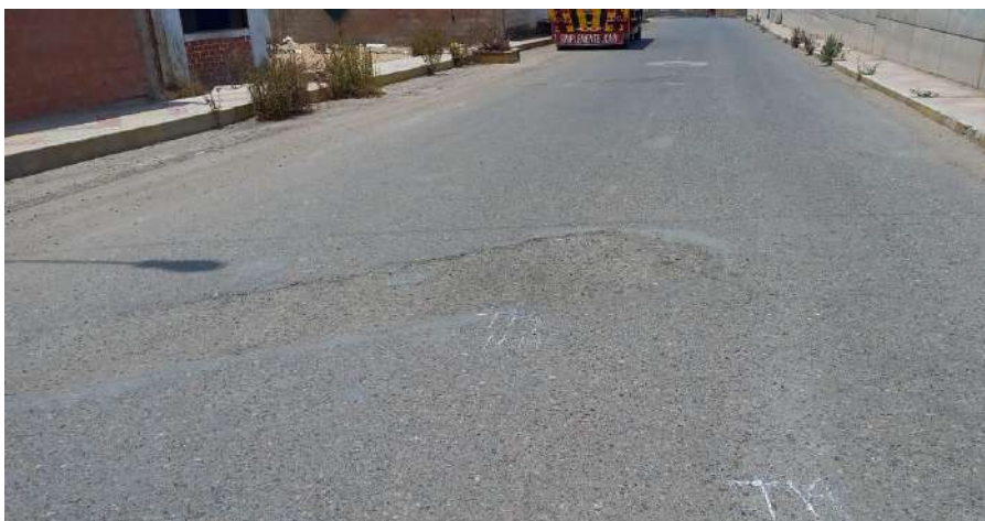
Unidad de muestreo U14 parcheo de severidad media
