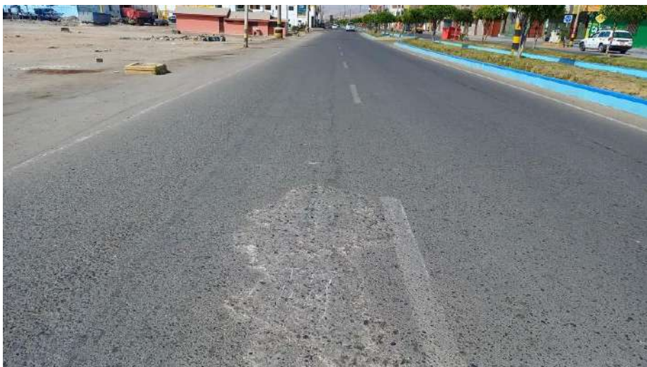
Unidad de muestreo U49 parcheo de severidad media
