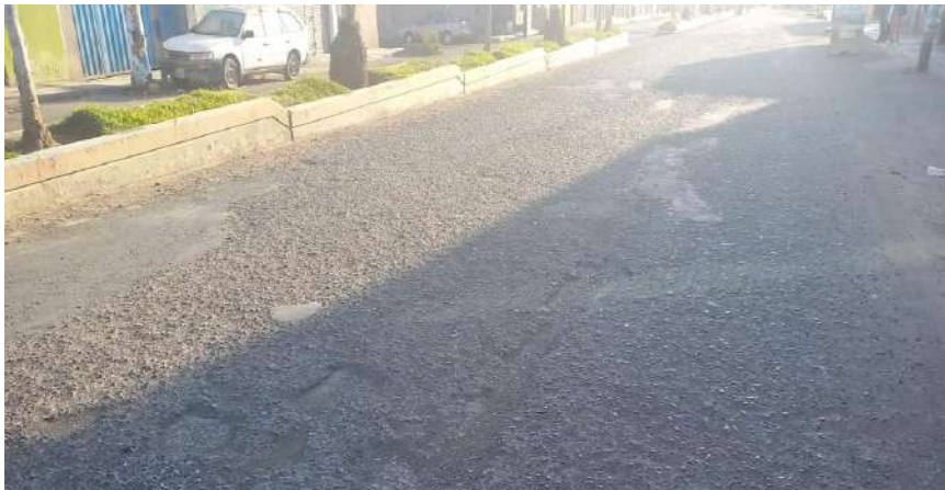
Unidad de muestreo U6 parcheo de severidad leve
