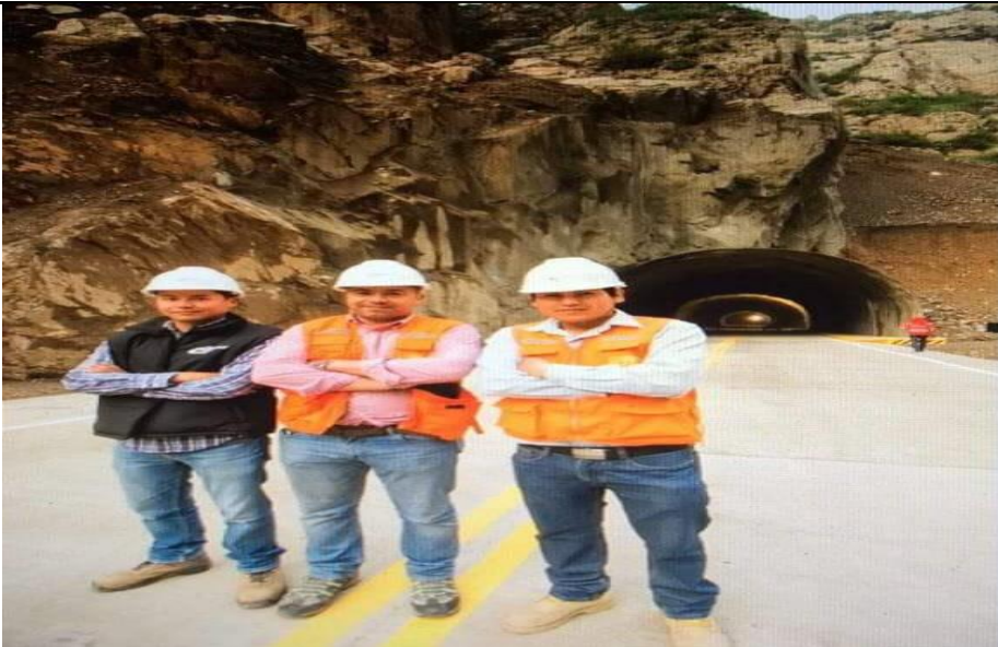
JM.I10_Finalización del Portal de Salida - Túnel Chacahuaro II.
