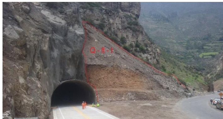
Figura N° 27: Terrazas Fluvio-Torrenciales, depositadas en el portal - túnel Chacahuaro II.
