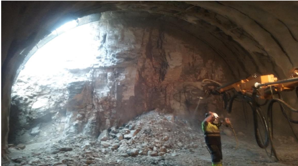
JM.I09_Sostenimiento con shotcrete y cerchas espaciadas cada 1m, al sistema de fracturas paralelas al eje del portal de salida del Túnel Chacahuaro II.
