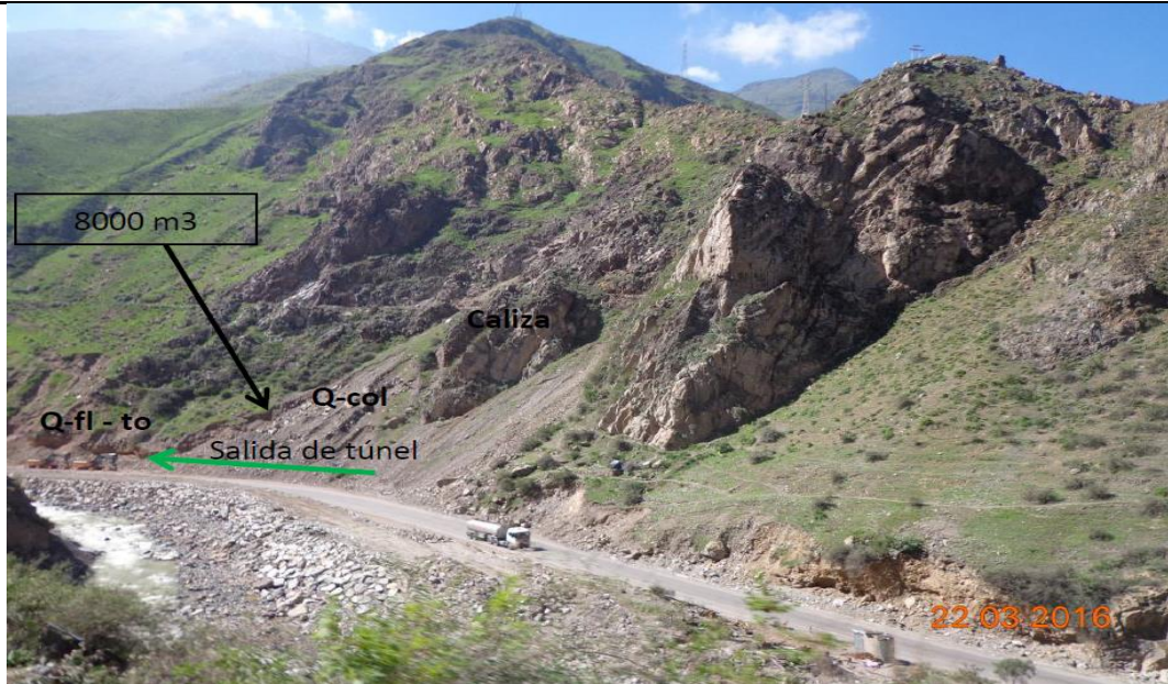
JM.I05_Vista del portal de salida del Túnel Chacahuaro II, Se muestra al macizo rocoso constituido por roca caliza y suprayaciendo depósitos coluviales y fluviotorrenciales.
