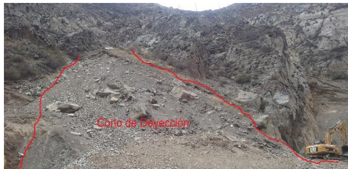
Figura N° 26: Cono de Deyección, escombros en el portal - túnel Chacahuaro II.
