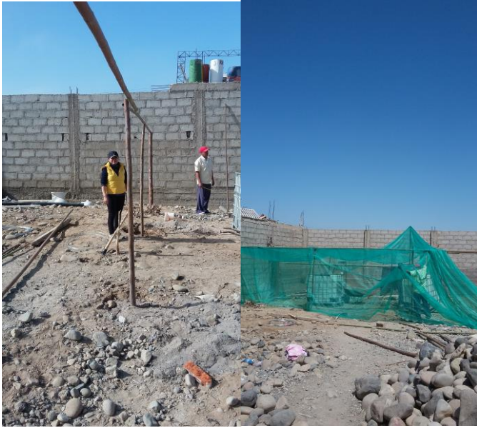
Figura 3: Construcción del invernadero
