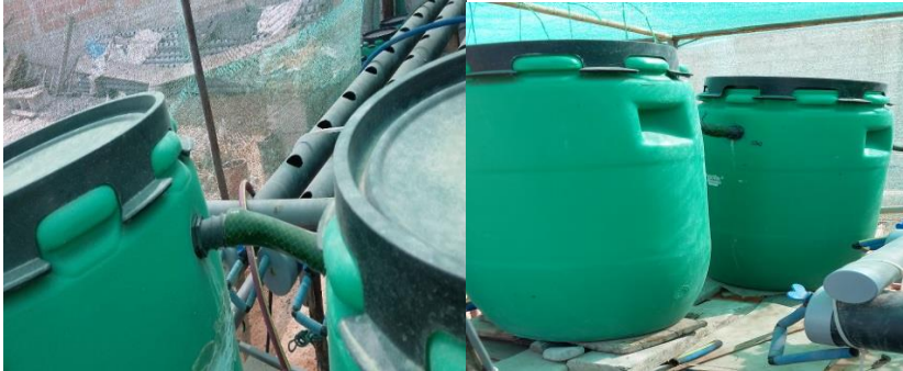
Figura 9: Instalación del biofiltro y decantador
