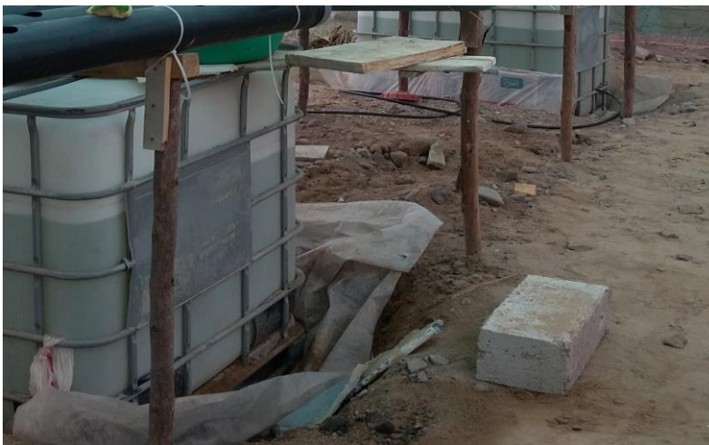
Figura 6: Instalación de estanques de 1000 lt cada uno
