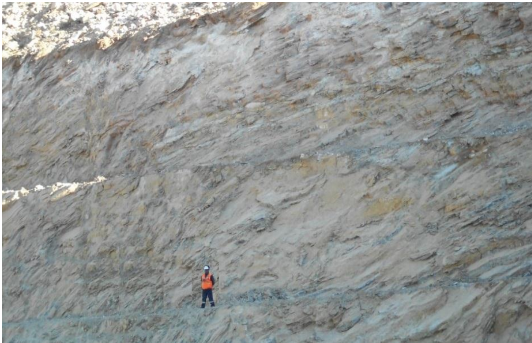
Figura 17: Bancos en construcción, mirando al este
