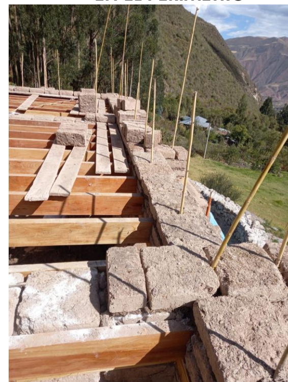
7 CUBIERTA DE BLOQUES DE ADOBE EN EL PERIMETRO
