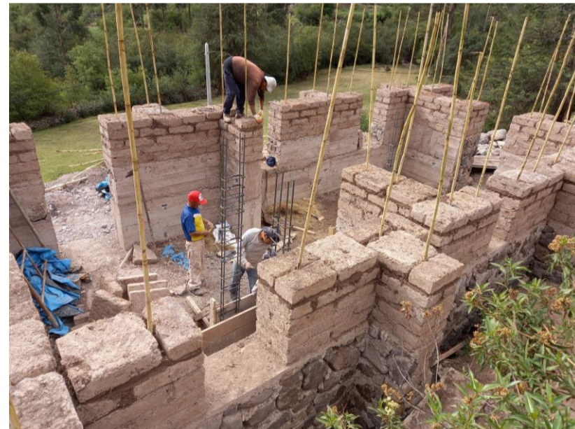
3 COLOCACIÓN DE BLOQUES DE ADOBE EN FILA CON AMARRES EN LAS ESQUINAS Y CAÑAS VERTICALES
