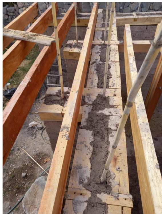
5 COLOCACIÓN DE VIGAS
