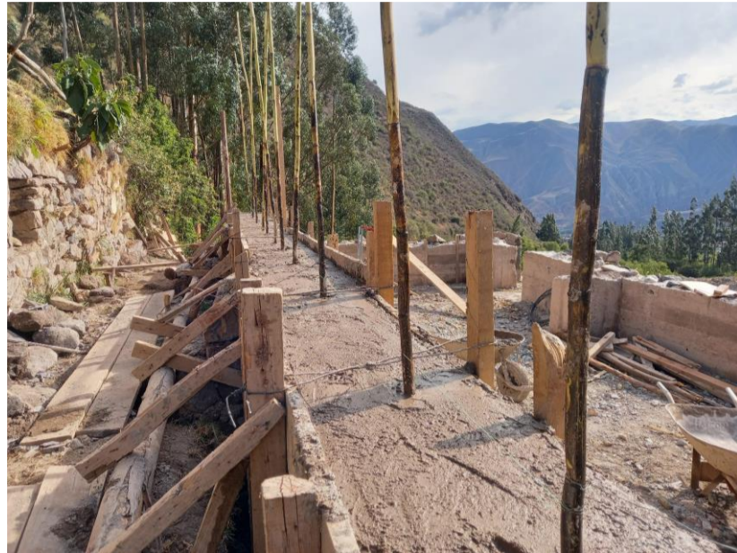
3 COLOCACIÓN DE BLOQUES DE ADOBE EN FILA CON AMARRES EN LAS ESQUINAS Y CAÑAS VERTICALES
