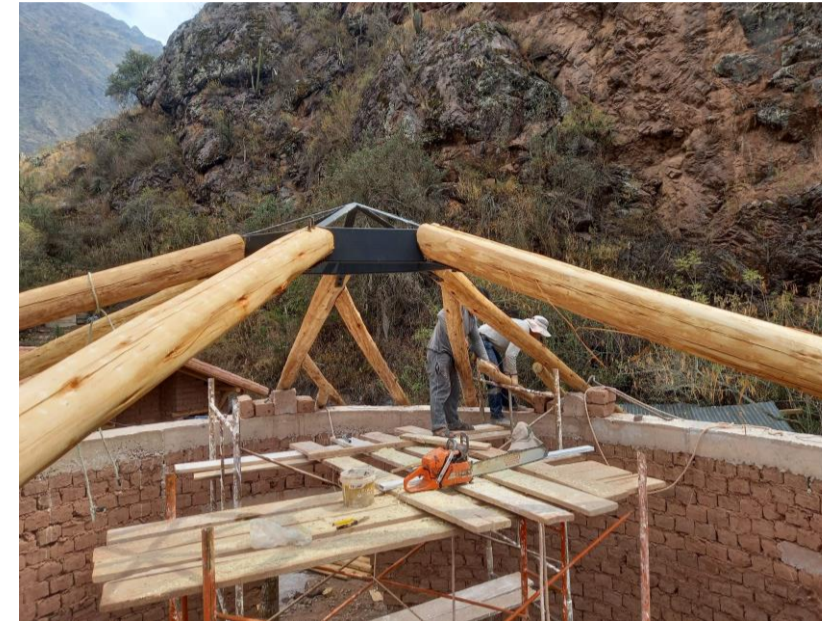
3 SE CUBRE CON SACO AZUL PARA QUE NO SE FILTRE EL AGUA
