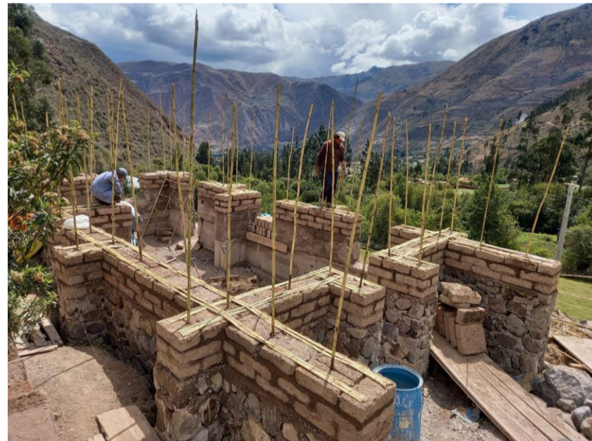
7 CUBIERTA DE BLOQUES DE ADOBE EN EL PERIMETRO
