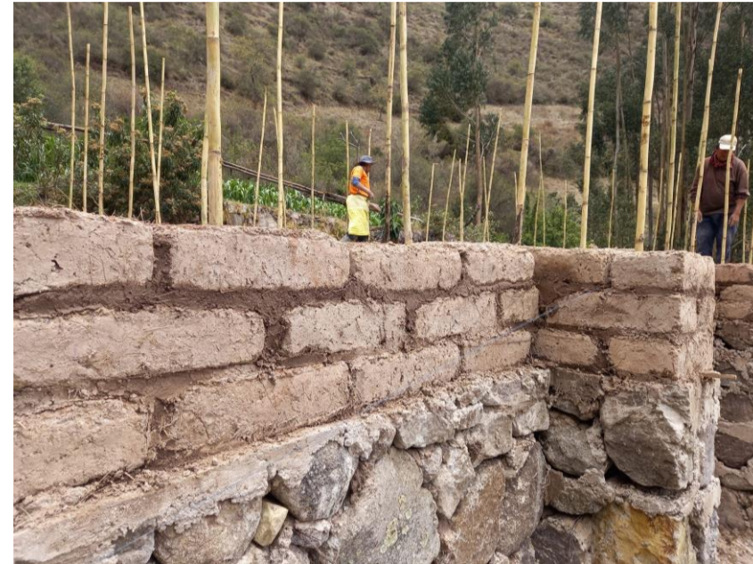
4 COLOCACIÓN DE CAÑAS VERTICALES Y HORIZONTALES PARA REFORZAR LOS AMARRES
