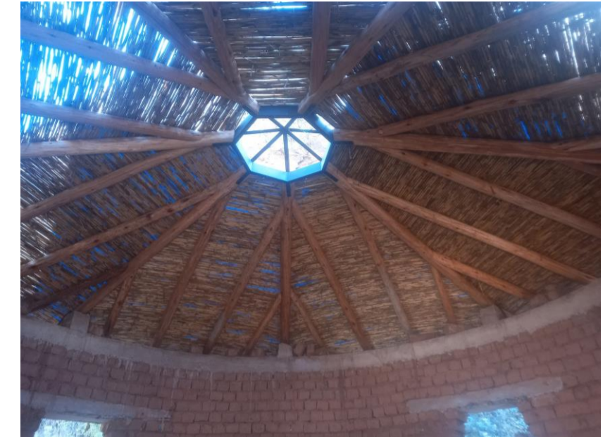
4 AL TERMINO SE COLOCA LA ARCILLA Y LAS TEJAS.
