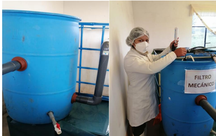
Figura 24. Filtro mecánico
