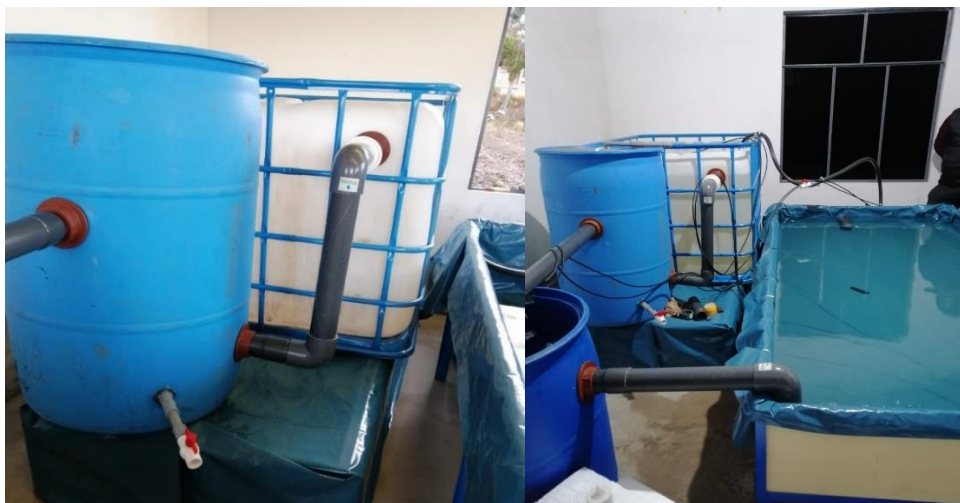
Figura 27. Instalación de tuberías
