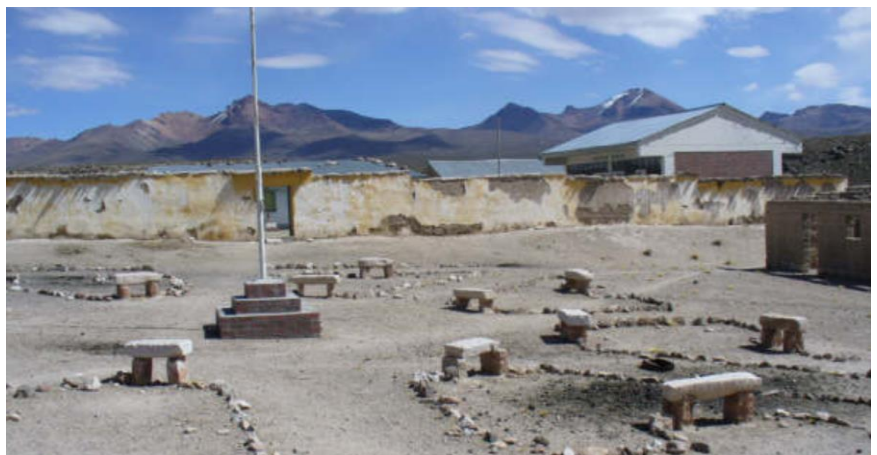
Cerco Perimétrico de Esteras - Palca
