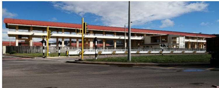
1 VISTA DEL ACCESO
