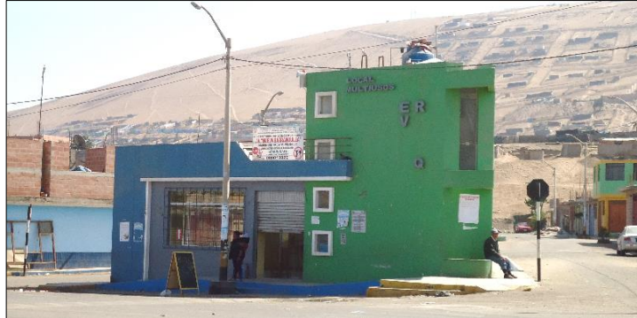
Figura 45. Edificación con sistema aporticado Fuente: Elaboración propia.
