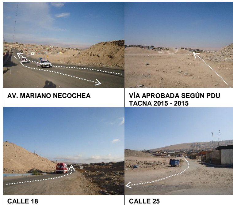
Figura 33. Condiciones físicas de las vías adyacentes al terreno
