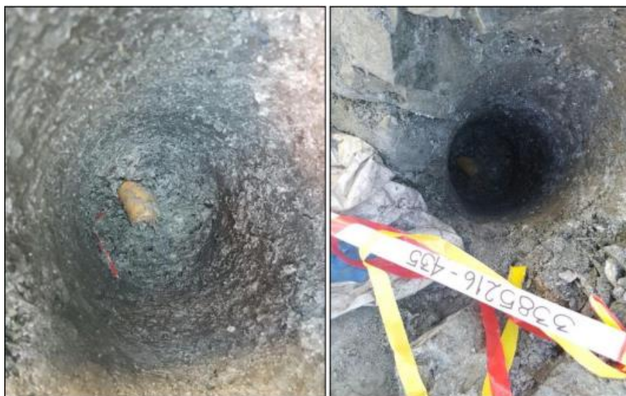
Figura 46. Vista del booster con detonadores encontrados en el fondo del taladro.
