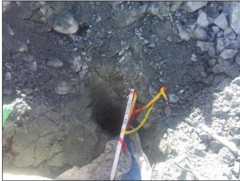
Figura 43. Vista del taladro (tiro cortado) y la estaca del replanteo topográfico del taladro.
