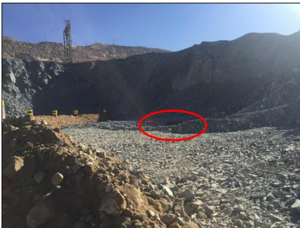
Figura 42. Zona donde se reportó el tiro cortado (líneas rojas).
