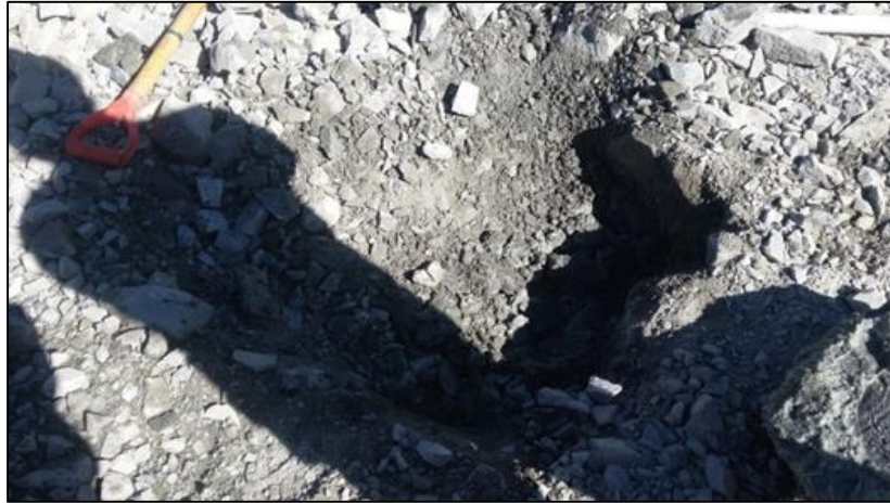
Figura 61. Excavación manual del punto identificado de tiro quedado.
