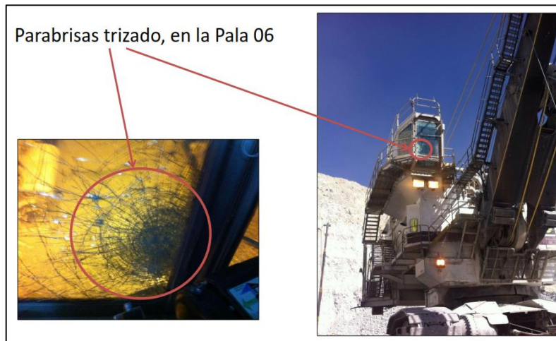
Figura 71. Pérdidas materiales causadas por el tiro fallado (T.C. y T.Q.).
