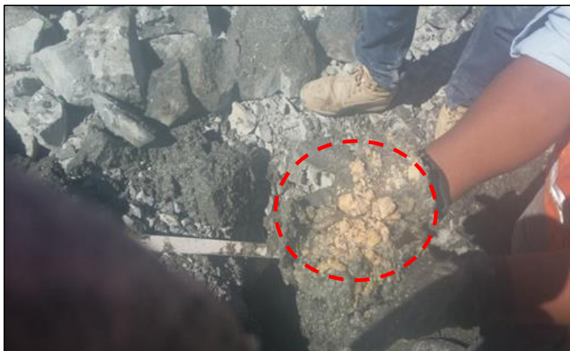
Figura 63. Identificación del booster en la excavación.
