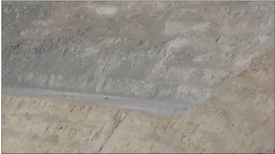
Figura 74. Antes de disparo proyecto 3070 195/174.
