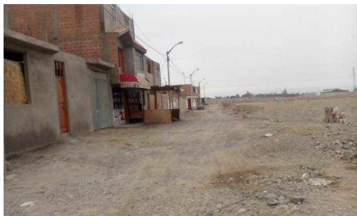
Figura 75: Vista vía secundaria – calle N° 5
