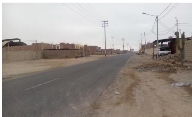
Figura 77: Vista de red de electricidad y alumbrado público, Vía Litoral
