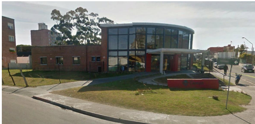
Figura 77: Vista de Fachada de CEREMA – Ciudad de Maldonado, Uruguay (Vista de Google Earth Pro – 2 016)
