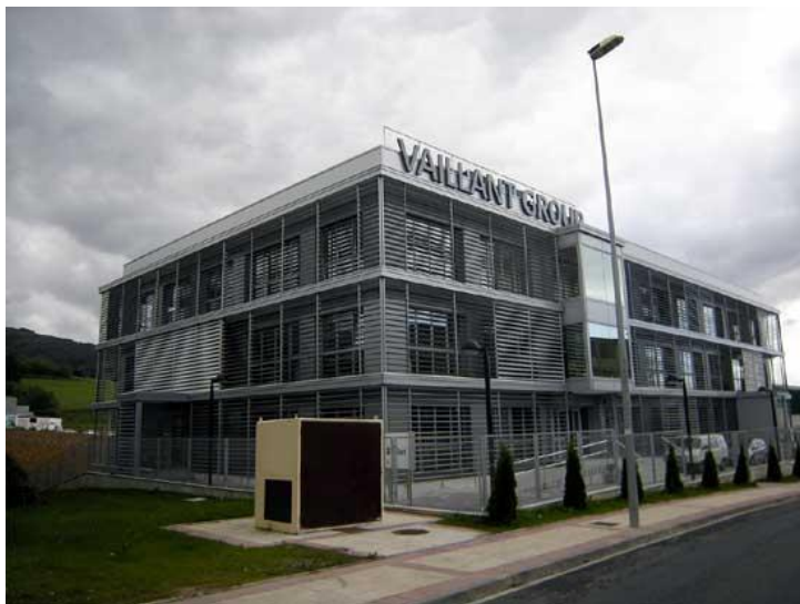
Figura 94: ejemplo de Celosía, Nueva sede de Vaillant Saunier Duval en Zamudi
