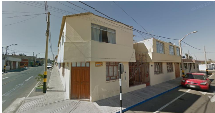
Figura 64: Vista de la fachada de E.L. MEDICAL CENTER
