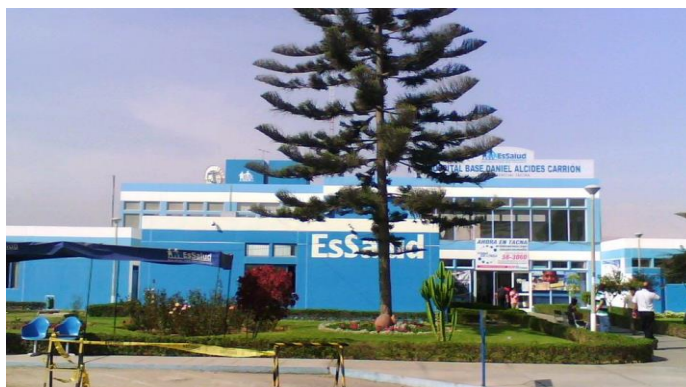
Figura 53: Vista EsSalud Tacna, Distrito de Calana
