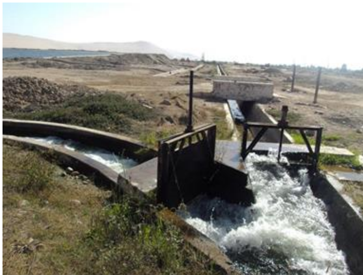
Figura 18 Compuerta del embalse Cerro Blanco
