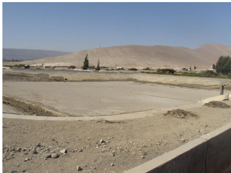
Figura 20 Embalse E-1 se encontró vacío por estar en mantenimiento
