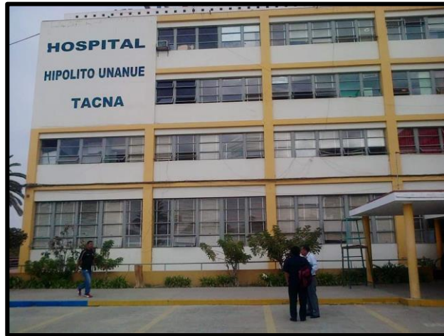
Hospital Hipólito Unanue de Tacna
