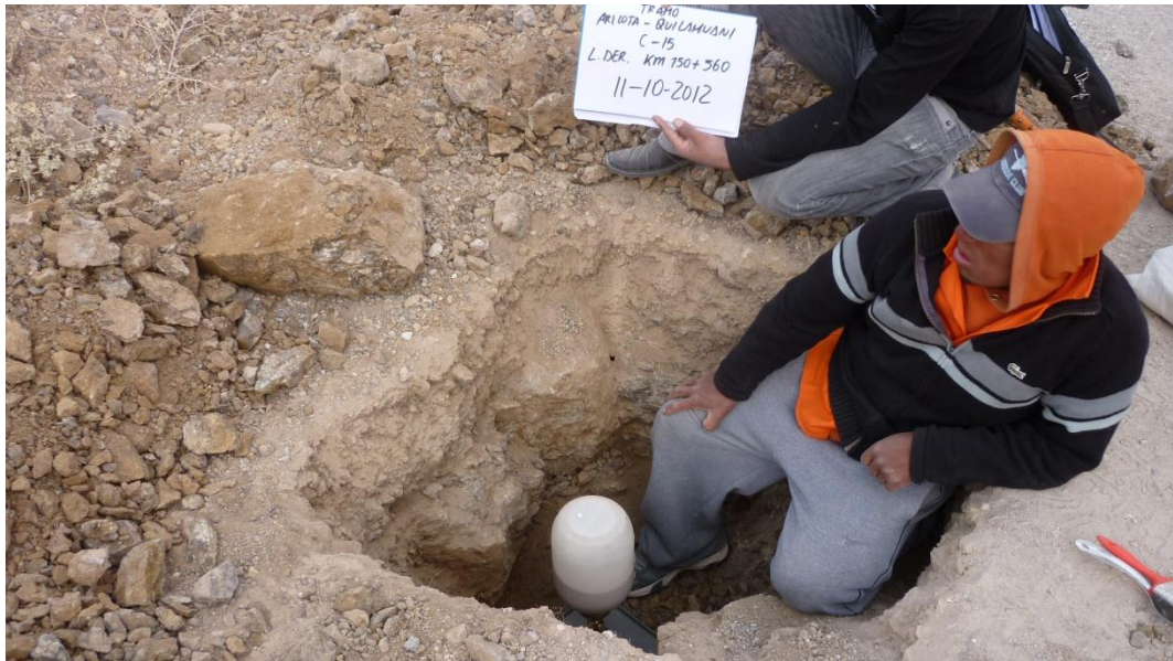
Calicata C-15.- Grava angulosa bien gradada con limos, no plástica de color gris y marrón oscuro. Diámetro máximo de 7 cm . A la profundidad de 0,85 m se encontró roca volcánica de la Formación Toquepala.
