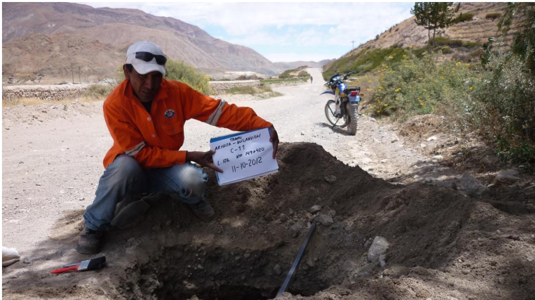
Calicata C-11.- Arena gruesa con grava subredondeada y angulosa pobremente gradado, no plástica de color gris oscuro y rosáceo. Diámetro máximo de 7 cm .
